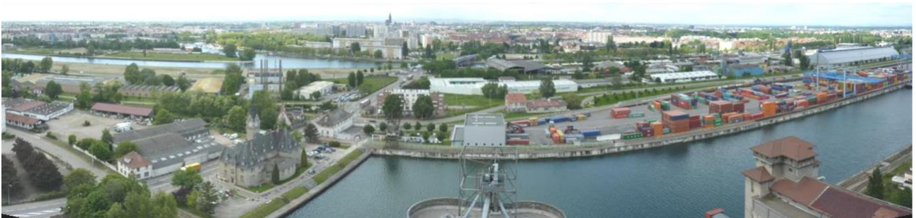
Vue vers l'Ouest : sites industriels, bassin du Commerce
