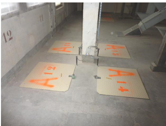
photo 13 (à droite) : les trappes sur cellules en bois de faible résistance ont été remplacées par des trappes métalliques résistantes (tôle larmée épaisseur 0,5 cm).
