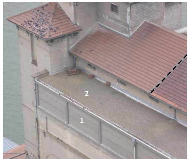
Photo 17 (à droite) : vue de la couverture sur cellules latérales. On distingue les panneaux de béton préfabriqués en 1 et la toiture terrasse en 2.
