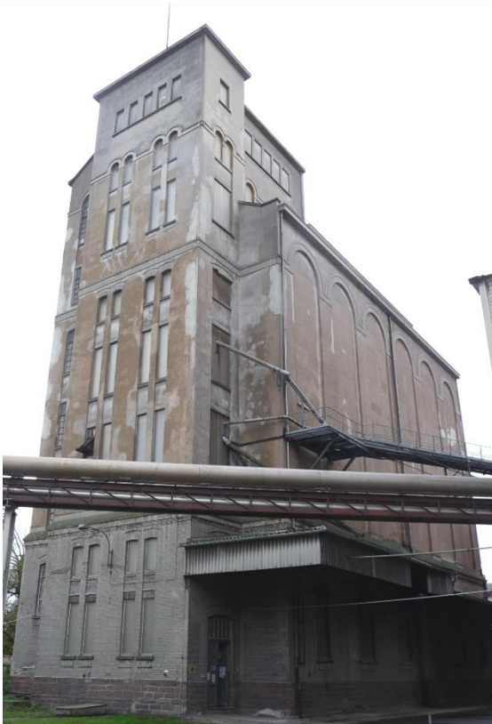
Photo 7 (à gauche) : vue générale extérieure du silo depuis le silo B. On distingue les étages de la tour (châssis) et le bloc cellules
