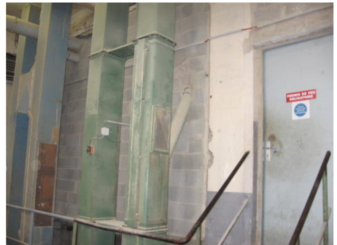
photo 12 (à droite) : passage découplé entre tour RDC et volume sous cellules.
