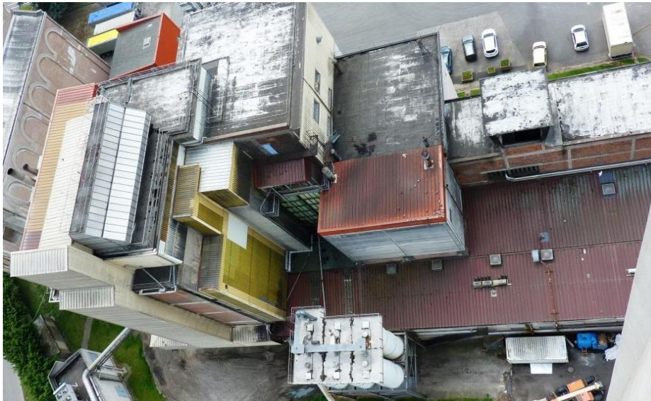
Photo 2 : vue générale aérienne arrière de M1 depuis la tour de germination M2
