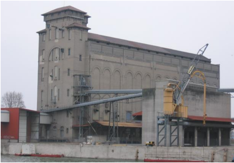
Photo 14 (à gauche) : vue générale du silo B. La toiture est réalisée en tuiles, les murs en briques et béton.
