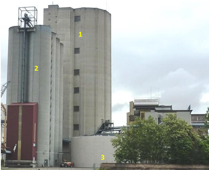
Photo 4 (à gauche) : vue de la tour de germination M2 (en 1) derrière le silo C (en 2) et de la zone touraille (en 3) depuis la darse
