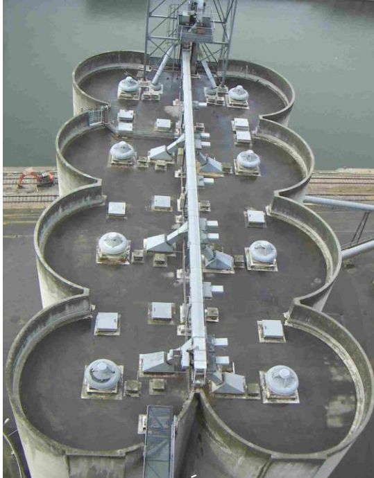
Photo 18 (à gauche) : vue de la zone sur cellules avec transporteur disposé en extérieur.
