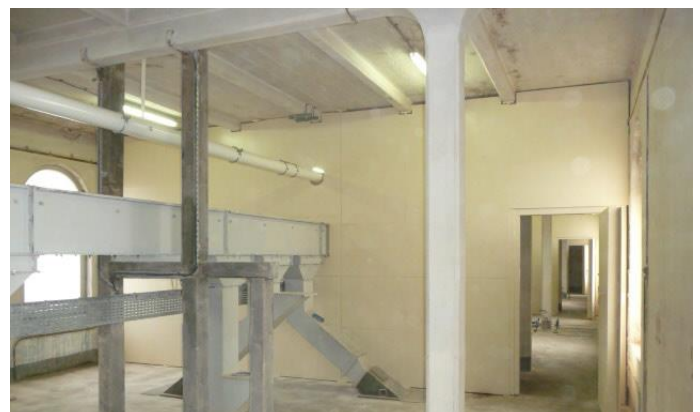
Photo 10 (à droite) : vue en enfilade des portes de passage au niveau des différents cloisons de découplage successives sur cellules
