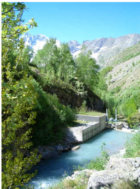
Vue amont rive droite
