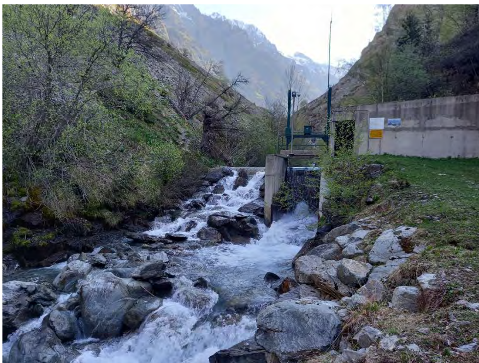
Photographie 1 : L'ouvrage de prise d'eau, mai 2022
