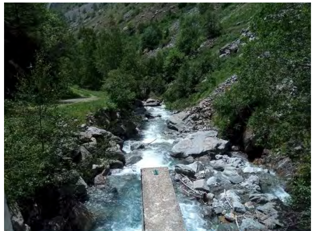
Photographie 2 : L'amont du TCC, depuis la prise d'eau de la SAFHSCO
