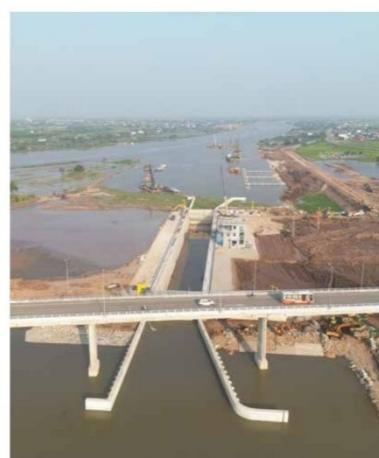
Au Vietnam, après plusieurs années d'études, CNR supervise en association avec Egis et son partenaire vietnamien VIPO les travaux de construction d'un canal de jonction entre deux bras du fleuve Rouge, équipé d'une écluse à grand gabarit et d'un viaduc routier.
