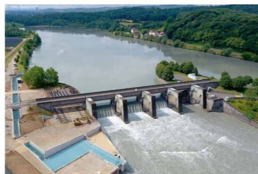
Ouvrage de franchissement piscicole de Villebois (01)
