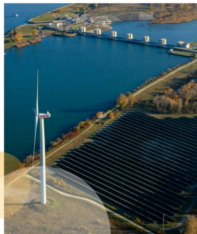
Barrage, parc éolien et parc photovoltaïque de Le Pouzin (07)
