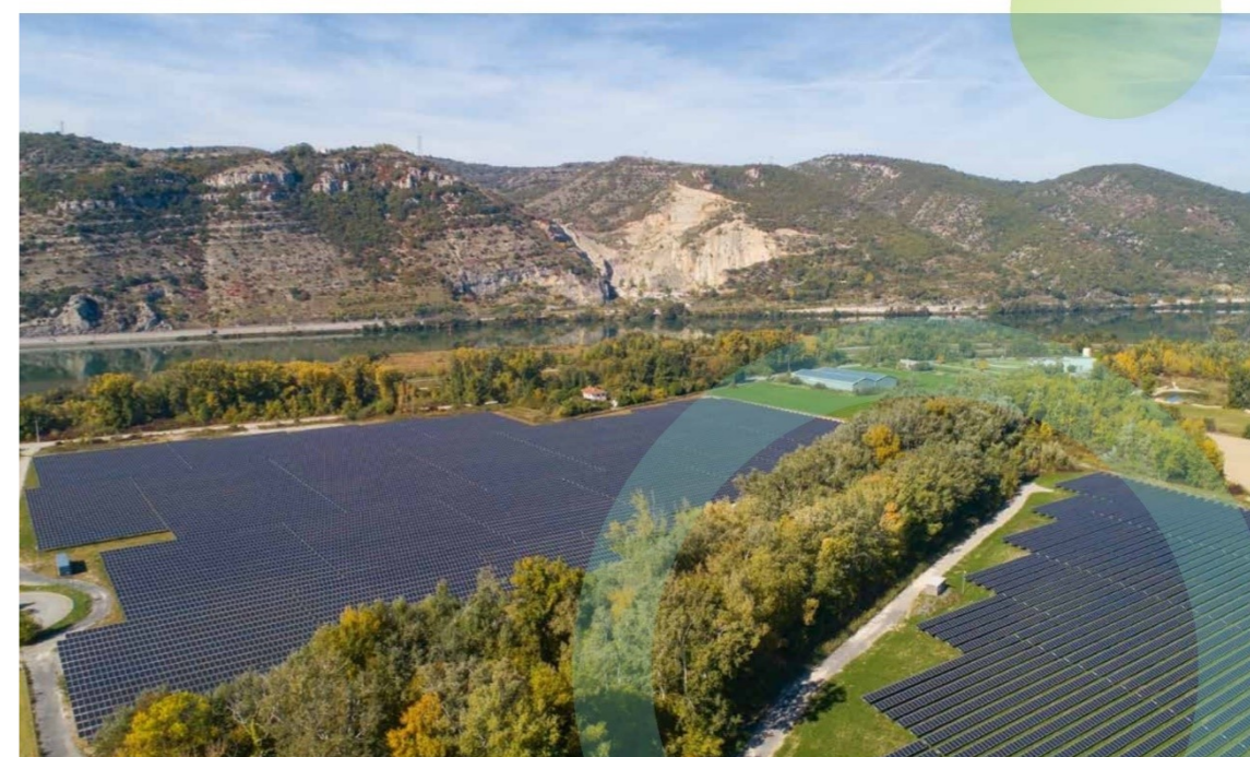
Parc photovoltaïque Le Pouzin 2 (07)
