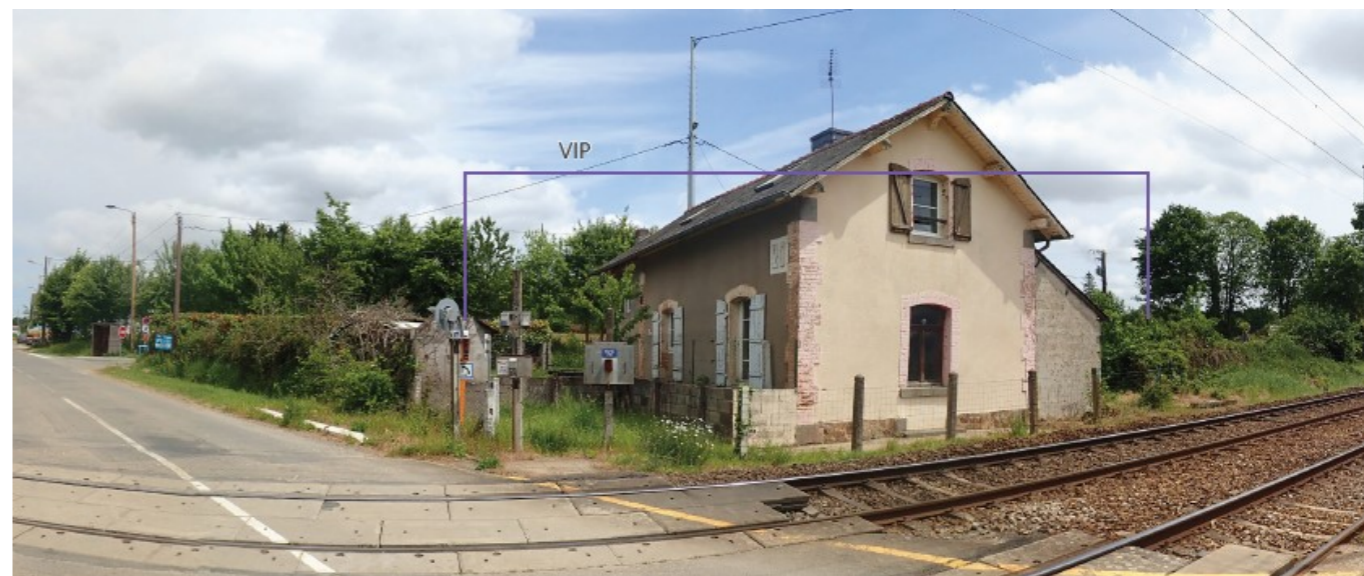
Photo 22 : la ligne TER Rennes-Saint-Malo passe à l'ouest de la zone du projet et les vues latérales alternent entre vues fermées par la trame végétale et vues ouvertes sur le milieu agricole ; le site du projet (VIP) est alors visible avec une prégnance visuelle forte par endroit
