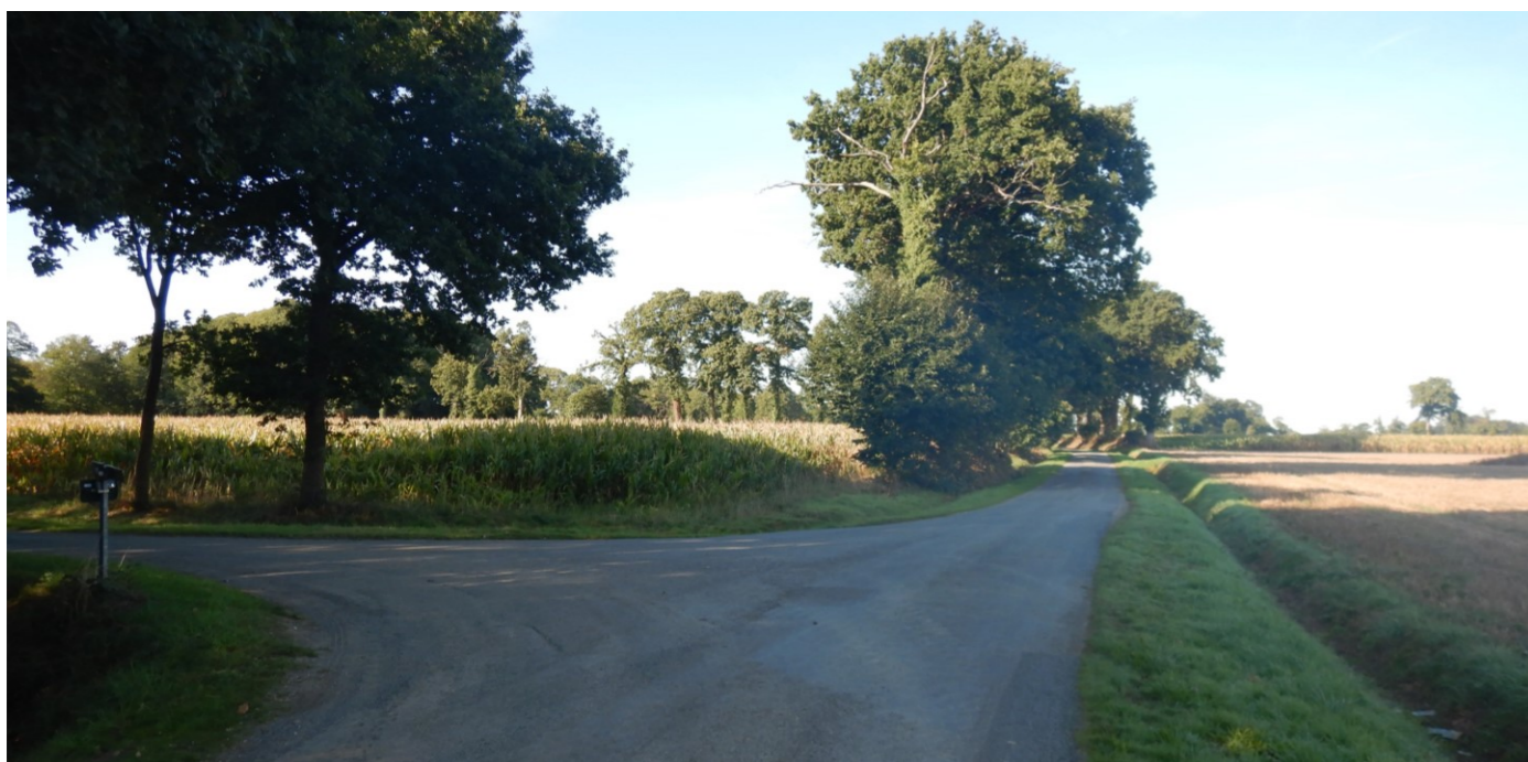
Photo 29 : croisement de voies communales aux abords de l'éolienne E2 dont les abords feront l'objet d'aménagements temporaires en phase chantier
