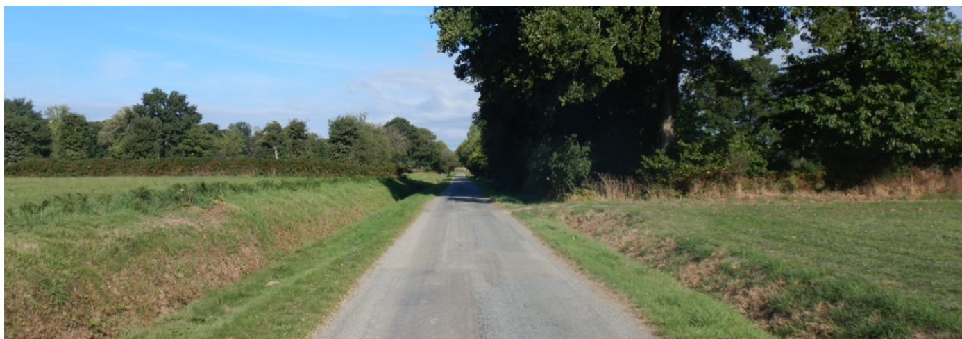
Photo 17 : voie communale à l'est de la zone d'implantation potentielle
