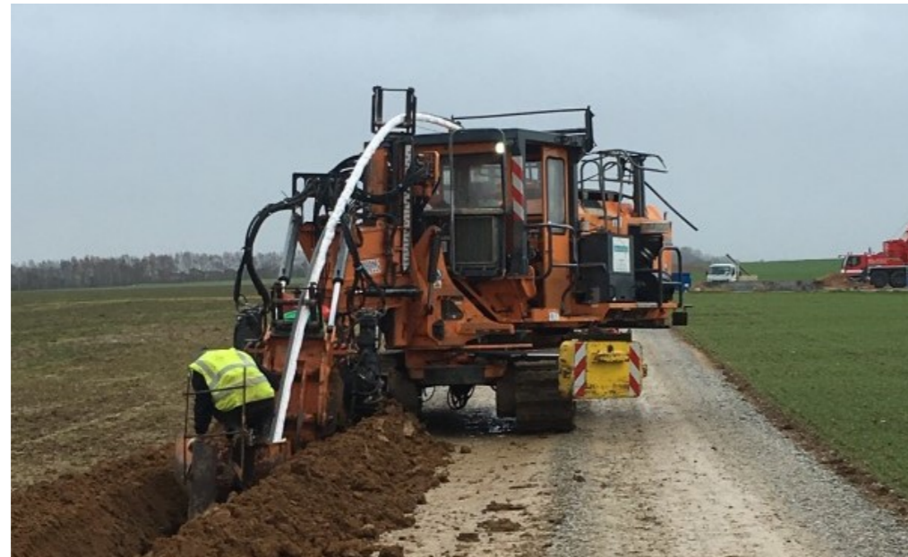
Photo 2 : mise en place du réseau électrique inter-éolien
