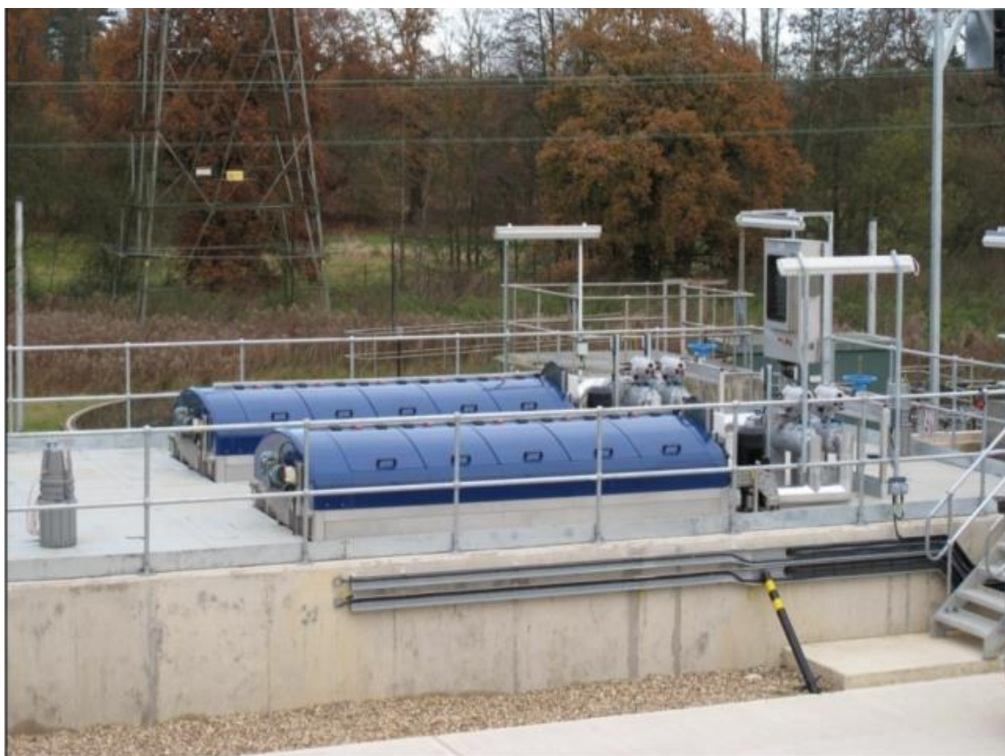
Figure 4 : Photos de réalisation
