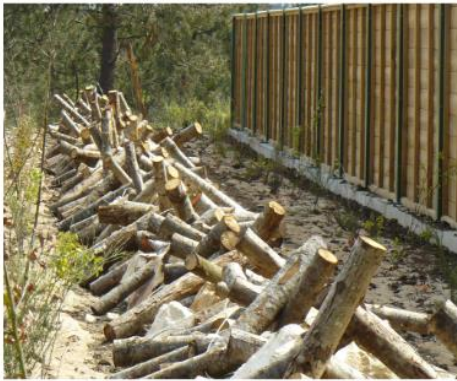
Photographie 2 : andain sur un écopont (A10 - DTer SO)
