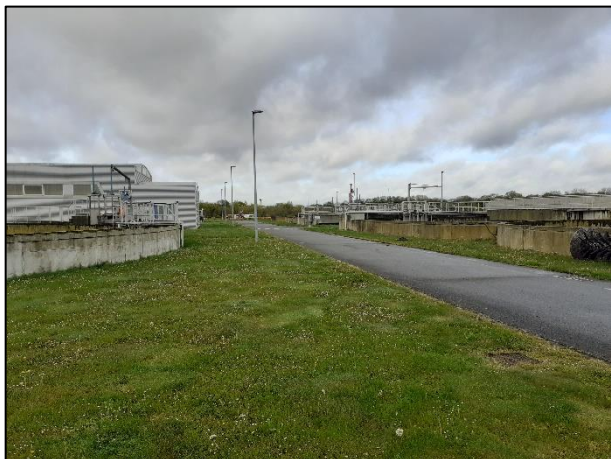
Photo 1. Pelouse tondues des espaces verts de la STEP
