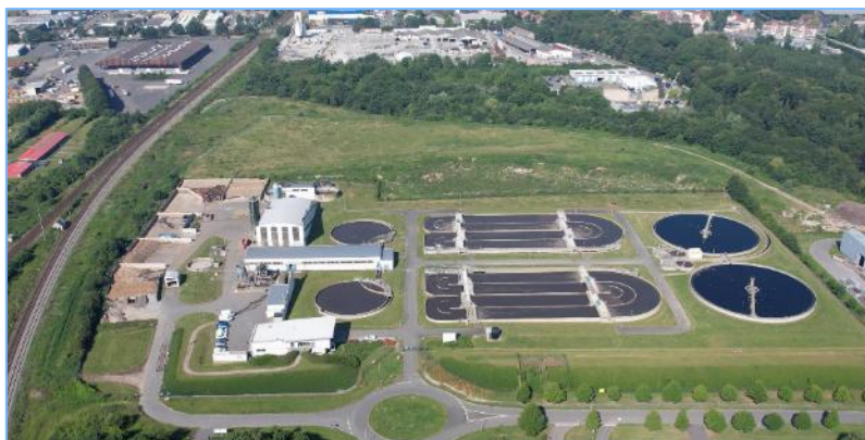
Figure 5 : Vue aérienne de la station d'épuration (Source : Veolia)
