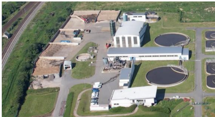
Figure 27 : Vue aérienne du prétraitement et du traitement des boues (source Veolia)
