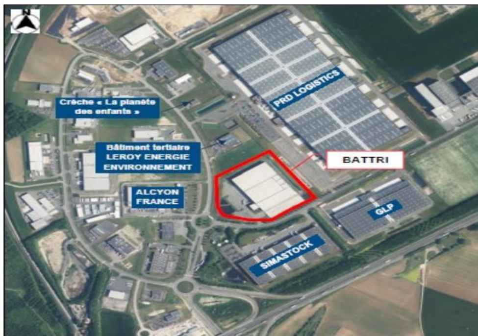
Figure 123 : Plan des abords du projet création d'une usine de recyclage de batteries (Source : avis n° 2024-8320 MRAe, 2024)
