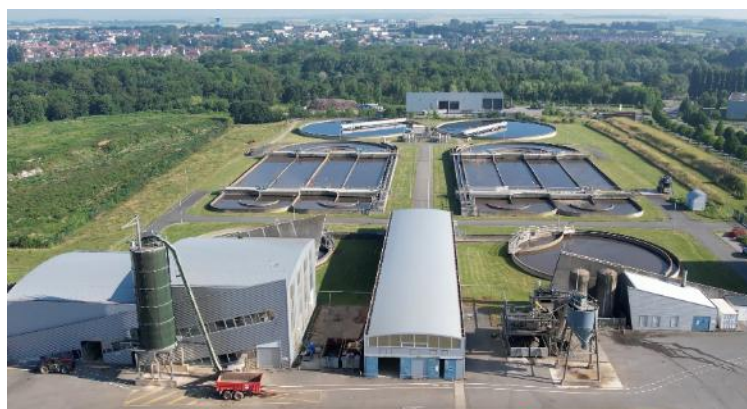
Figure 95 : Photographies aériennes de la STEP
