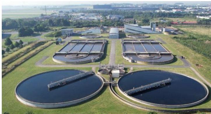
Figure 25 : Vue aérienne de la filière de traitement de l'eau (source Veolia)
