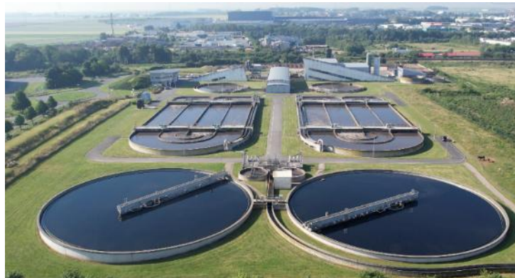
Figure 27 : Vue aérienne de la filière de traitement de l'eau (source Veolia)
