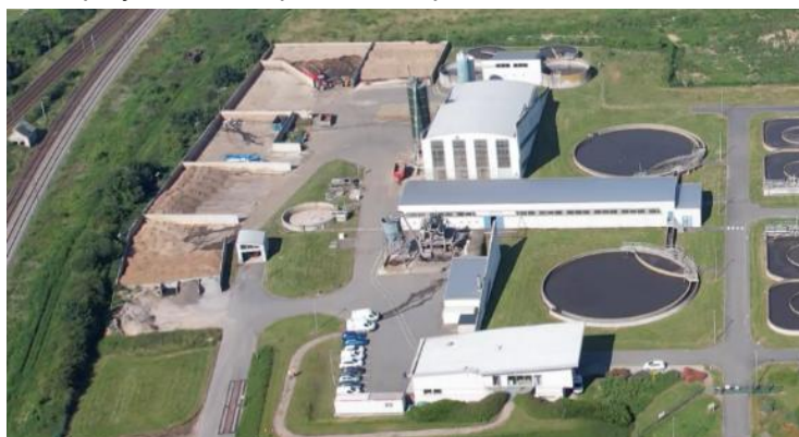
Figure 29 : Vue aérienne du prétraitement et du traitement des boues (source Veolia)
