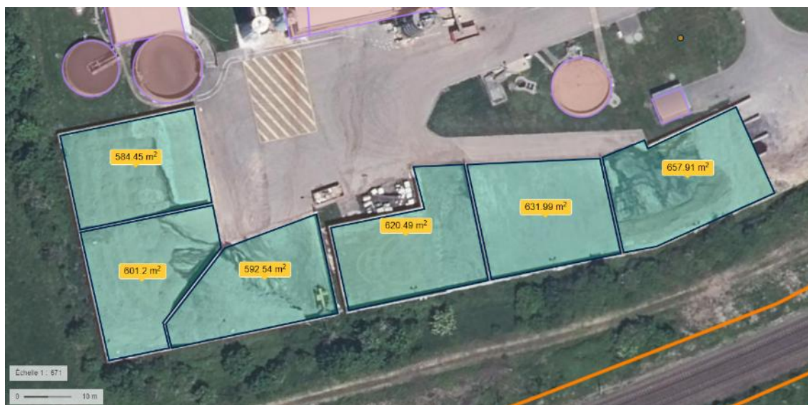
Figure 30 : Boxes de stockage des boues déshydratées
