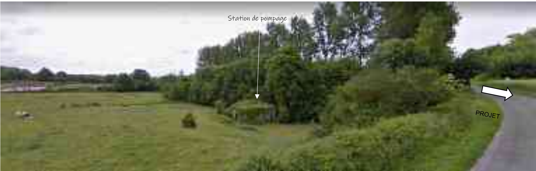
Photo 63 : Station de pompage depuis la D133 (Source : Googlemaps)
