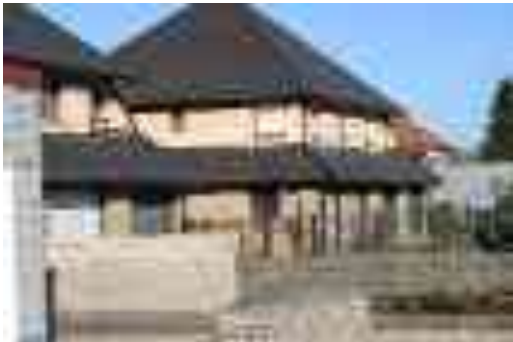
Photo 20 Architecture moderne briques et tuiles grises (Source : EPURE)
