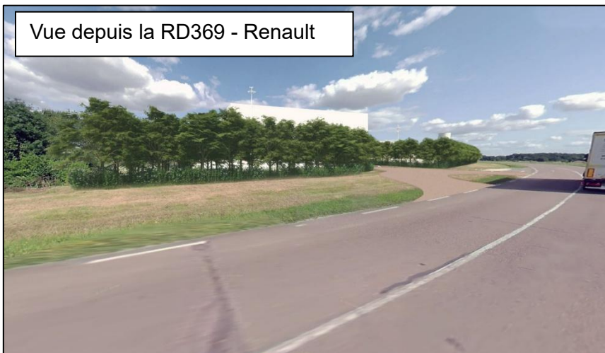
Vue depuis le sud
