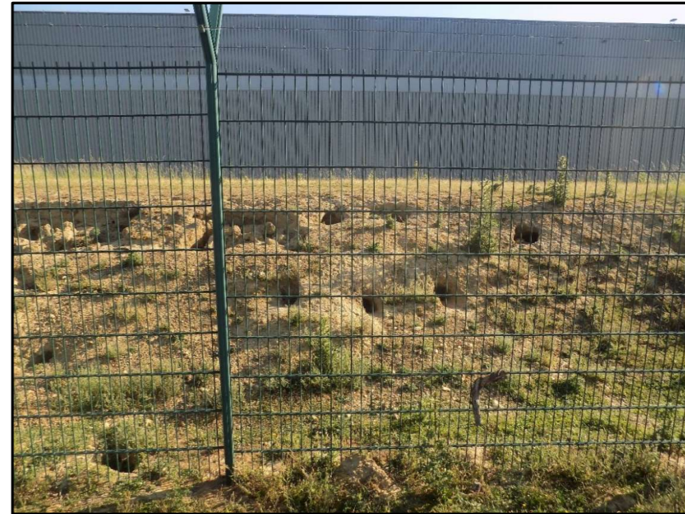
Figure 17 : Garenne de Lapin au niveau des talus
