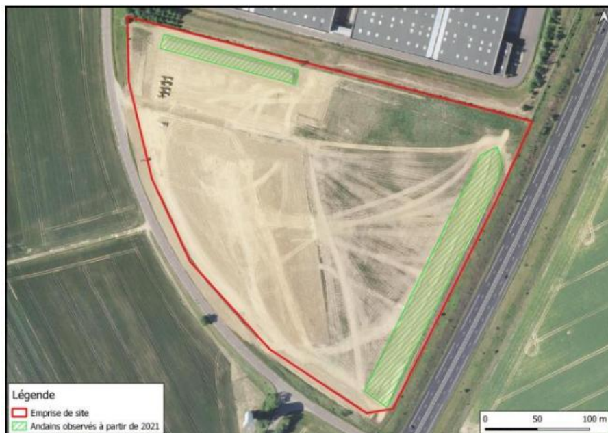
Figure 1 : Vue aérienne datant de 2021 (source : géoportail)
