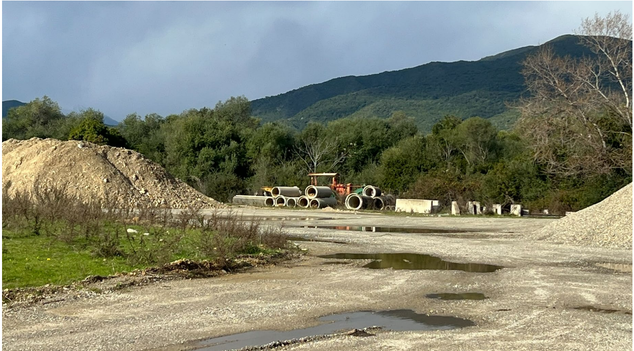
Engin de chantier et matériaux de génie civil entreposés. Etat des sols. Vue depuis la parcelle concernée.
