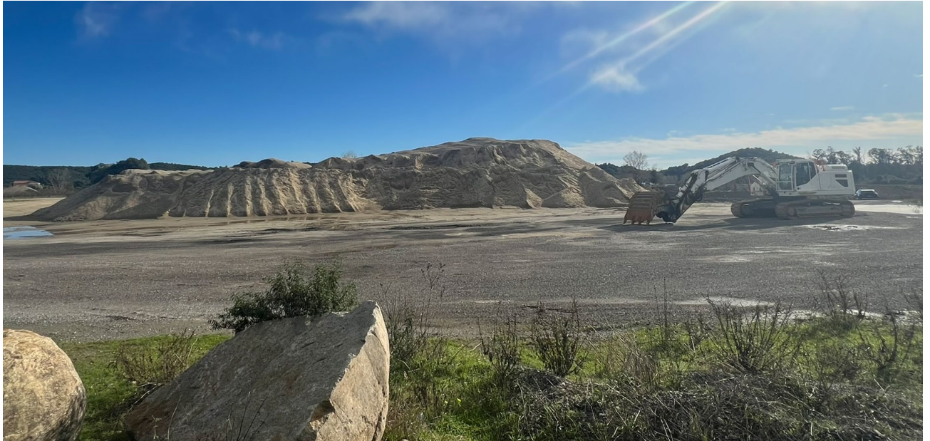
Stock de minéraux. Vue en direction de la future zone d'exploitation. Echelle donnée par l'engin de chantier
