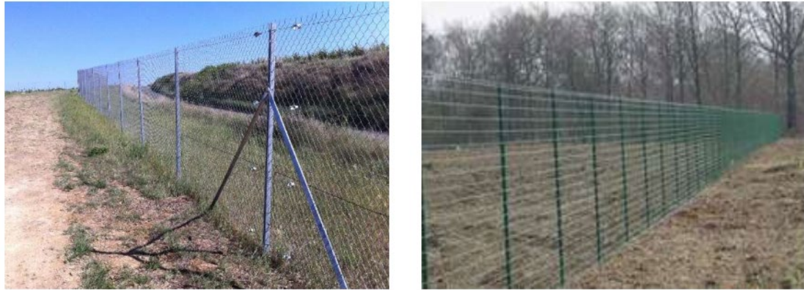
Exemples de clôtures – source : TSE
