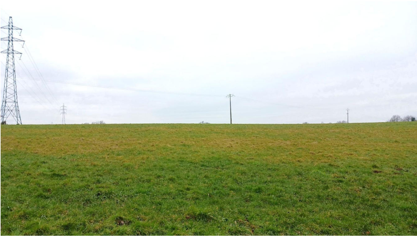
Figure 32 : Lignes aériennes HTB (à gauche) et ligne HTA (à droite) traversant le site – Vue depuis le nord-est
