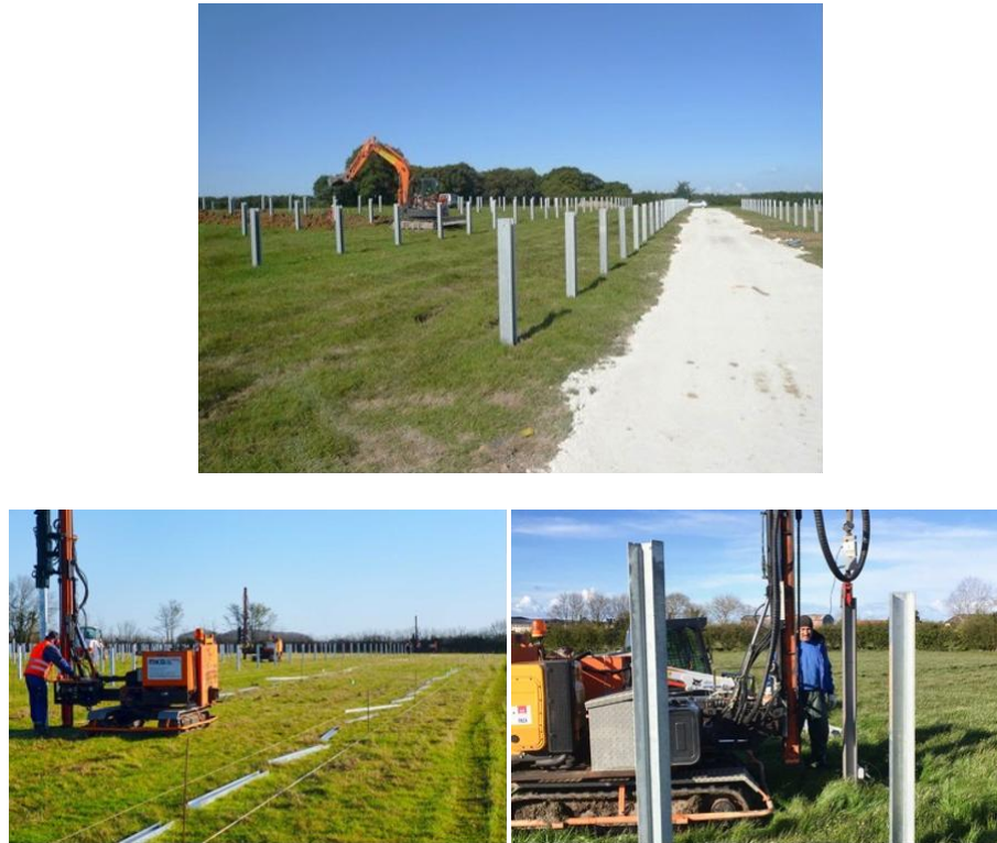
Figure 108 : Illustration des pieux battus mis en œuvre avec profil en coupe (TSE, 2025.)
