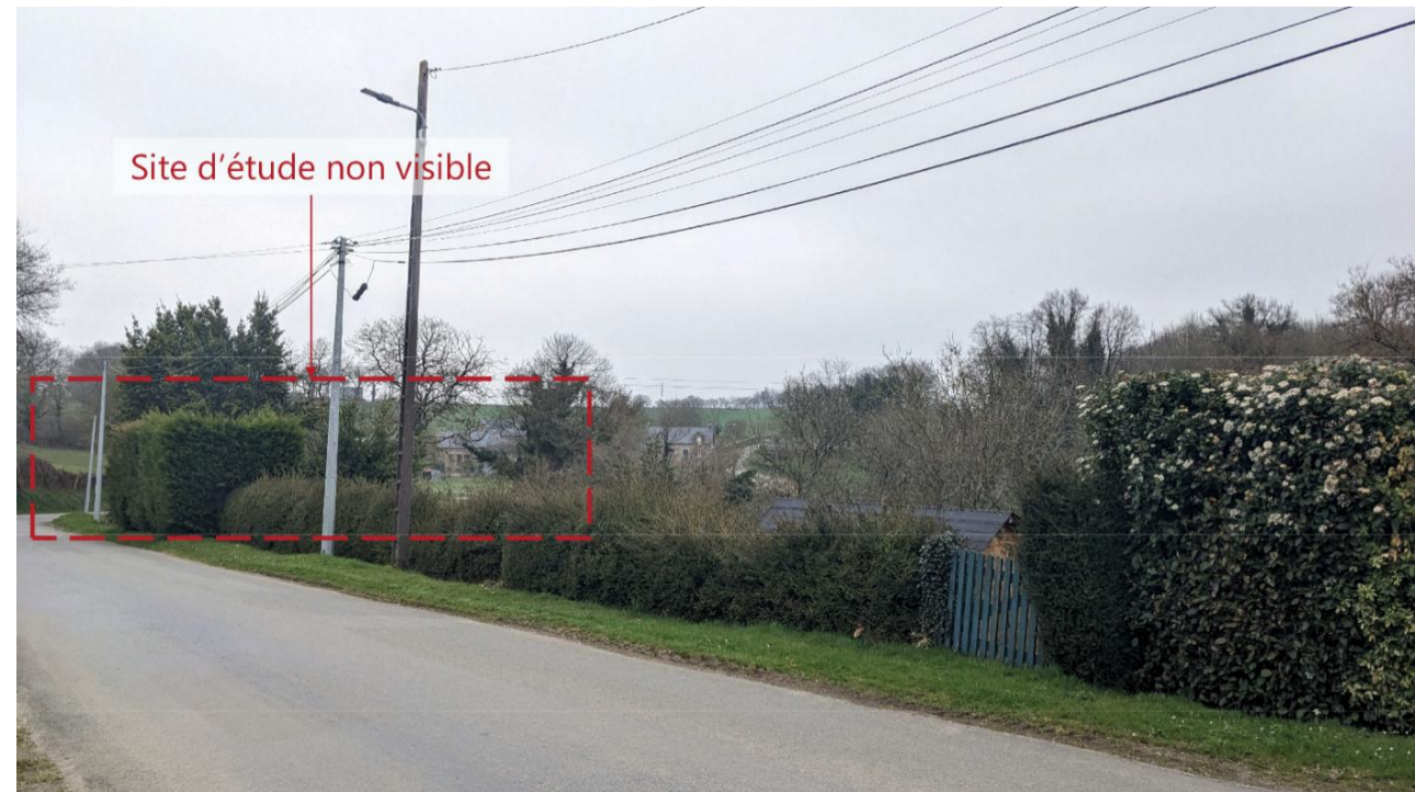
Figure 78 : Vue Q vers le site depuis l'ouest du bourg de Le Horps
