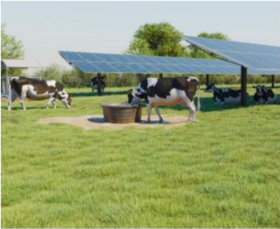
Figure 95 : Image 3D des ombrières photovoltaïques d'élevage (TSE, 2025.)
