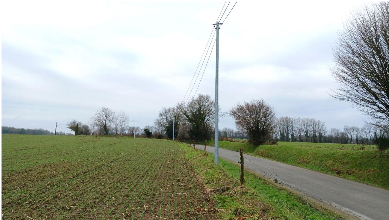
Figure 33 : Lignes télécom en limite de site – Vue depuis le nord-ouest
