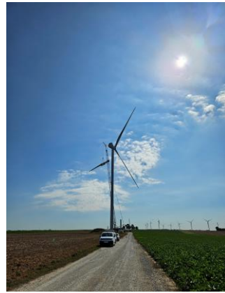
Photo 10 : Assemblage du rotor en l'air (Source : wpd)
