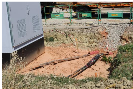
Photo 7 : Câbles souterrains reliant les éoliennes au poste de livraison avant enfouissement (Source : Ora environnement)
