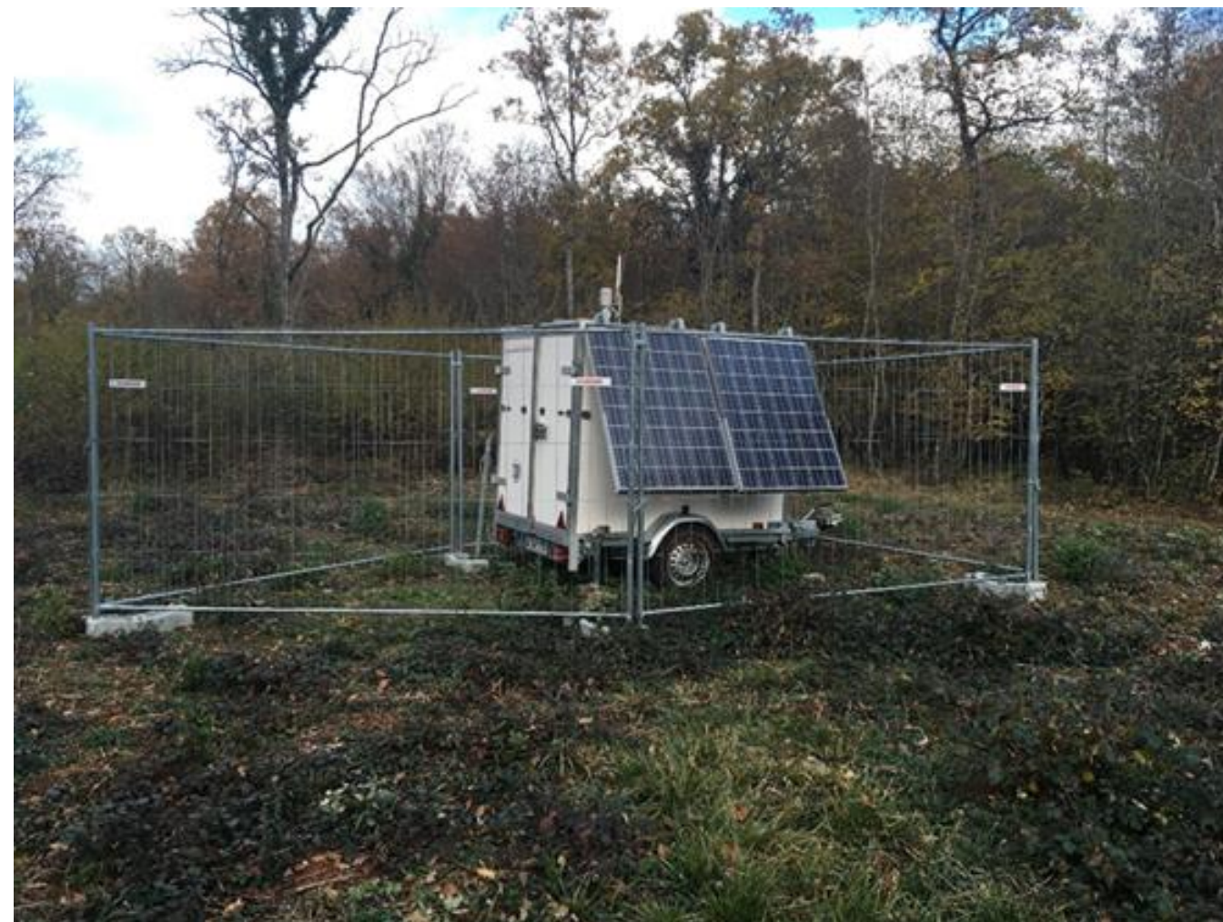
Photo 12 : Installation d'un dispositif LIDAR (Source : wpd)
