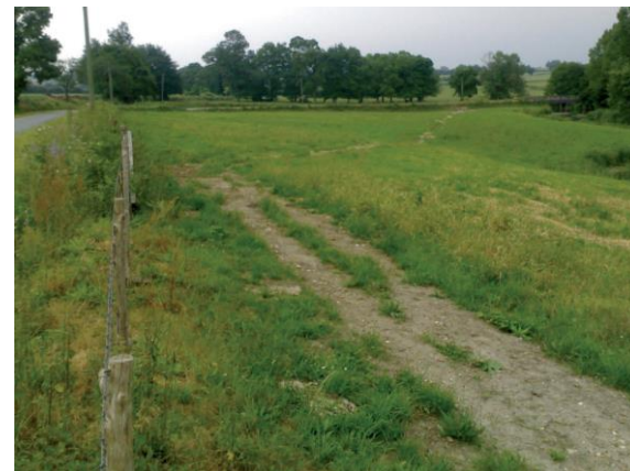
Photo 6 : Exemple de tranchée fermée depuis 2 mois
