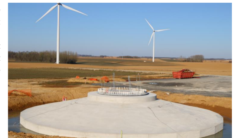
Photo 2 : Fondation avant recouvrement
