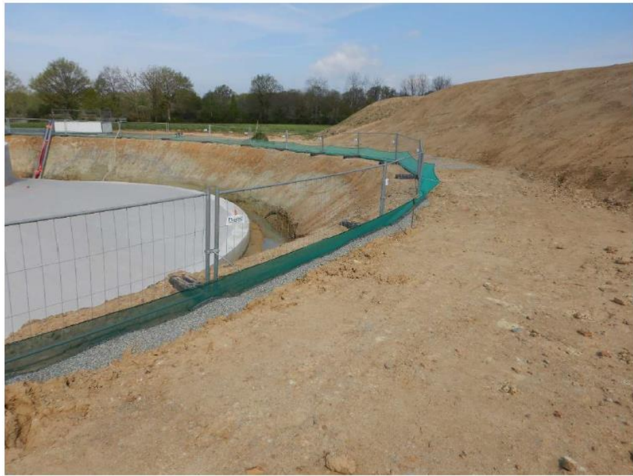
Photo 35 : Exemple de mise en défend d'une fouille d'éolienne (Source : Encis)
