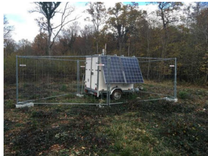
Photo 2 : Installation d'un dispositif LIDAR (Source : wpd)
