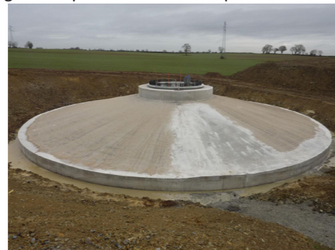
PHOTOGRAPHIE D'UNE FONDATION D'ÉOLIENNE
