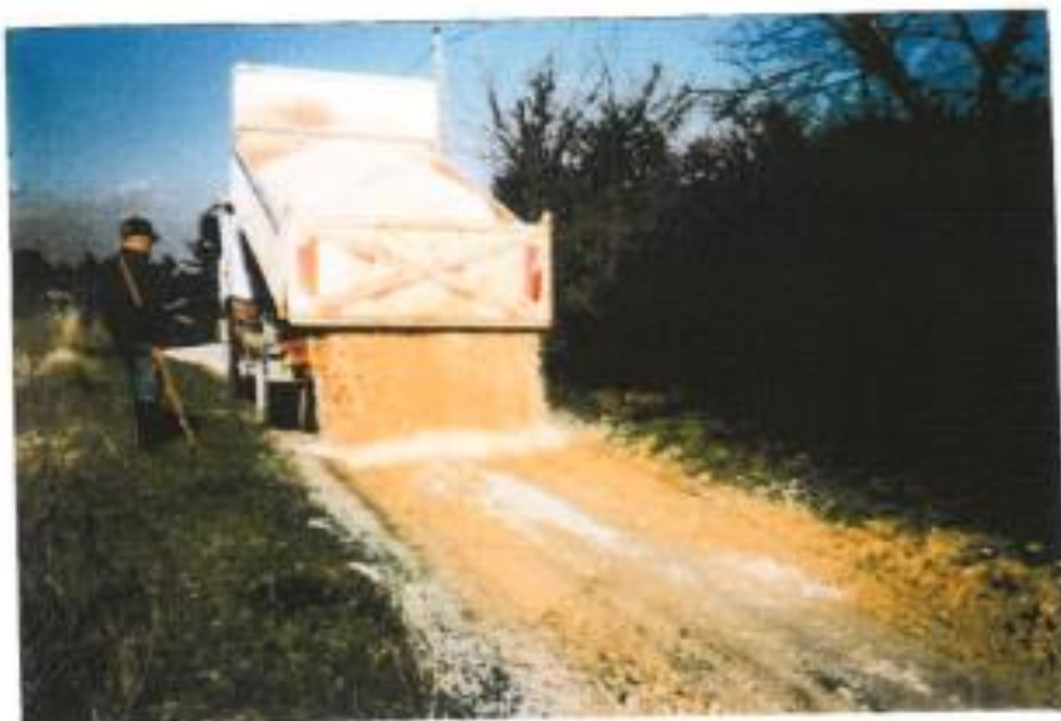
Planche 3 - Février 1997 - Recharge du chemin à nos frais avec 5m3 de tout-venant
