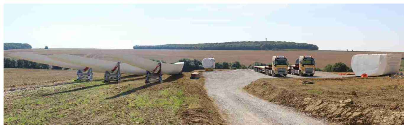
Éléments d'éoliennes avant montage (Source : Ora environnement)
