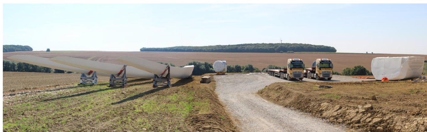
Éléments d'éoliennes avant montage (Source : Ora environnement)
