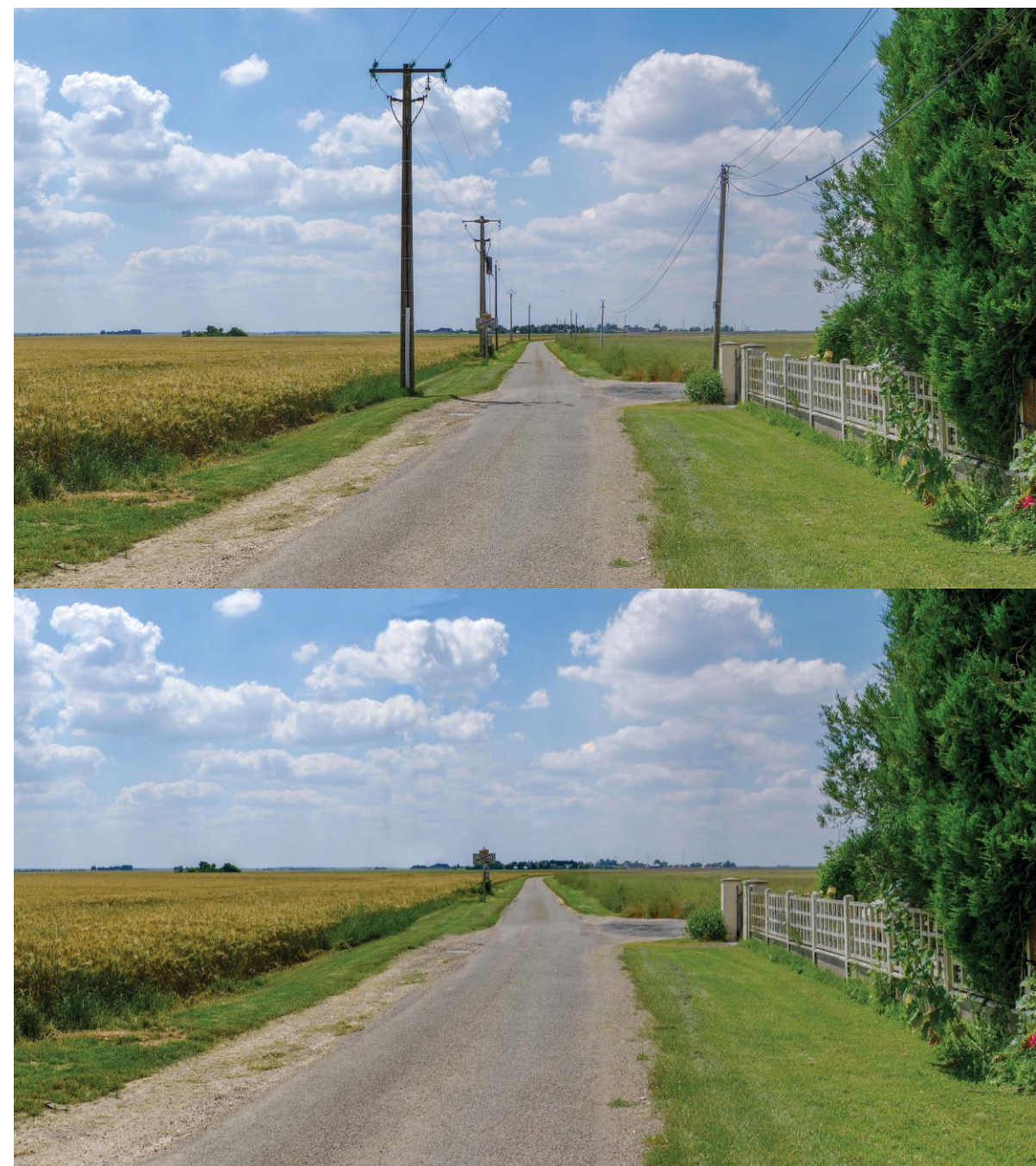
Photo 6 : Simulation de l'ambiance paysagère à la suite d'un enfouissement du réseau électrique depuis l'ouest de Neuvy-en-Dunois, sur l'axe routier D153.3, en direction de Melleville
