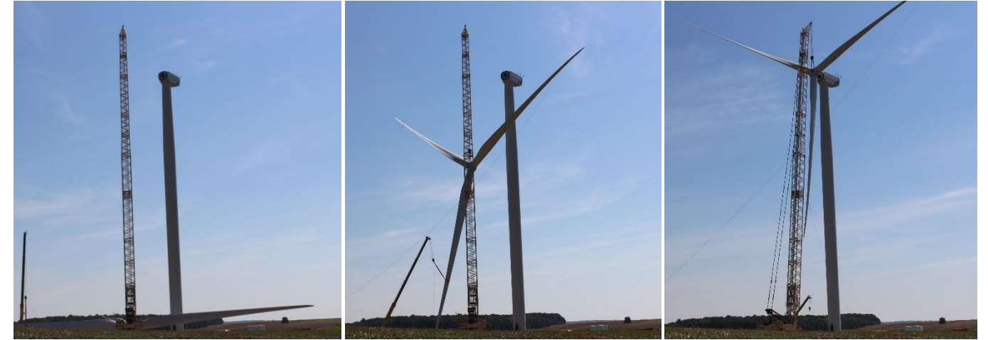
Photo 6 : Etapes du montage du rotor d'éolienne (Source : Ora environnement)
