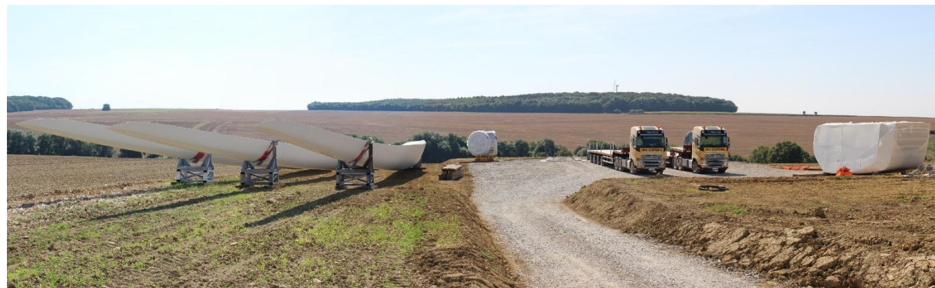
Photo 5 : Eléments d'éoliennes avant montage (Source : Ora environnement)
