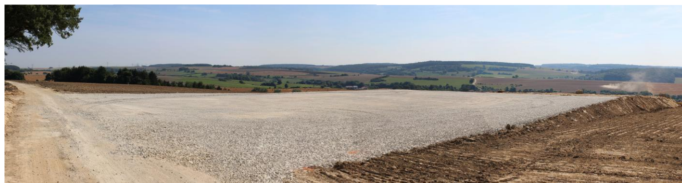
Photo 2 : Plateforme de montage d'éolienne (Source : Ora environnement)
