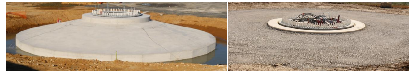
Photo 3 : Fondation d'éolienne avant et après recouvrement (Source : Ora environnement)
