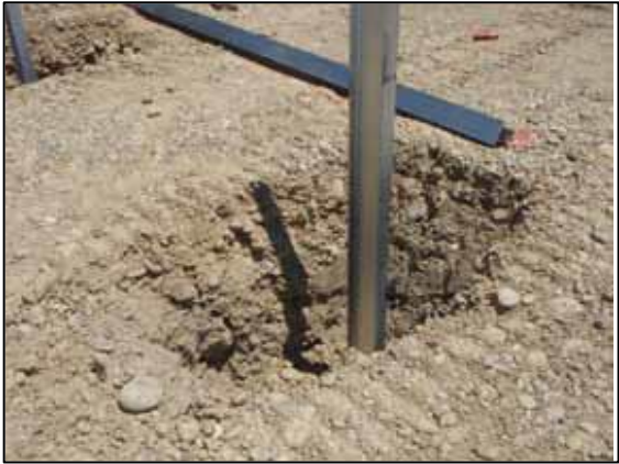
Figure 15 : Types de fondation - pieux battus (Source : Guide MEDDTL 2011 – NCA, 2015)
