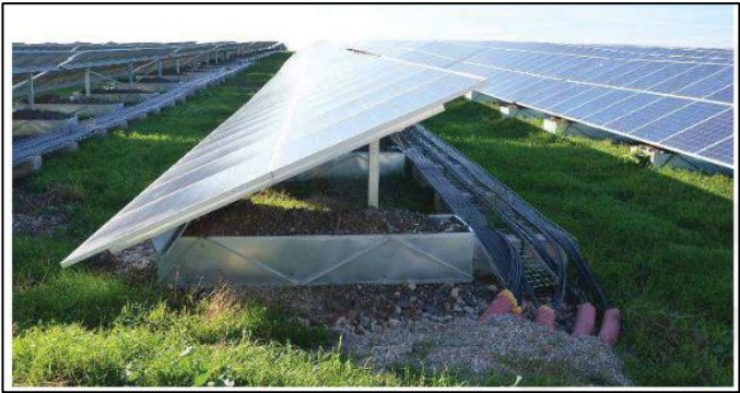
Figure 17 : Fixation par des gabions (Source : Quadran)
