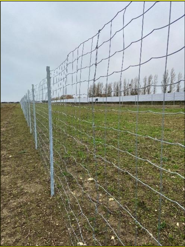
Figure 25 : Illustrations d'une clôture à maille progressive laissant passer la petite faune (Source : BayWa r.e.)
