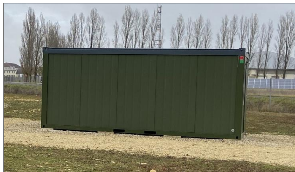
Figure 45 : Container de stockage
