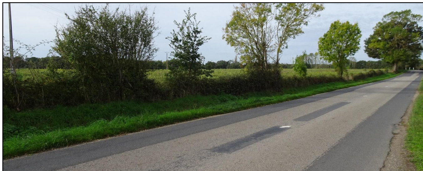
Figure 234 : Photographie de la route D 117 qui longe une partie du site d'étude (Source : NCA Environnement)
