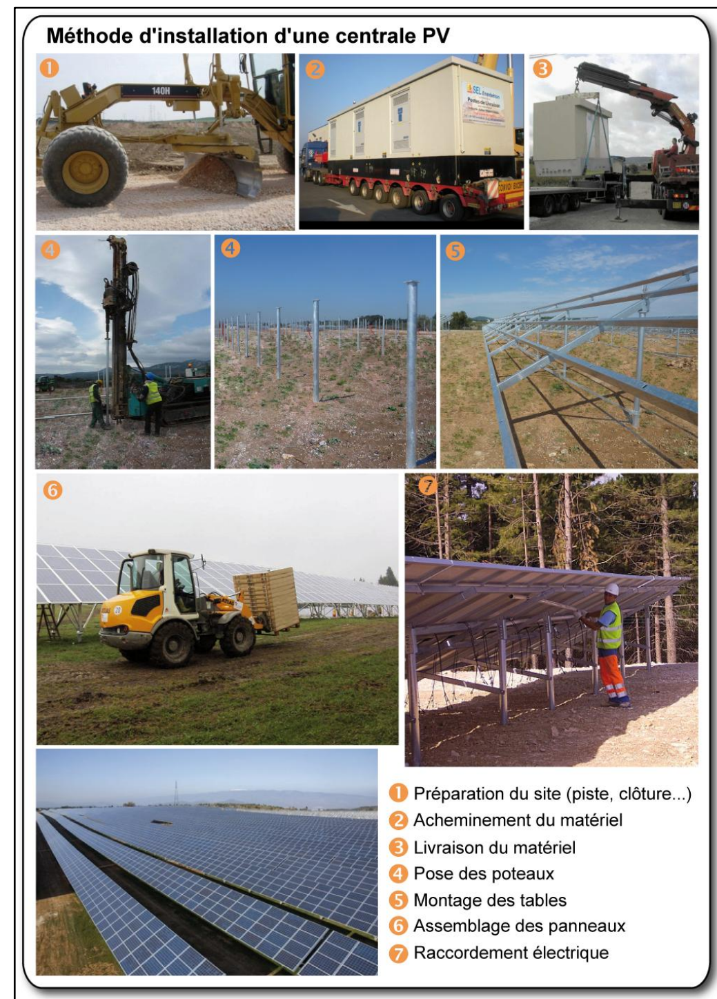
Figure 50 : Construction d'une centrale photovoltaïque (Source : BayWa r.e.)
