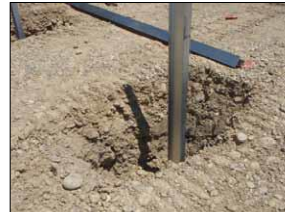
Figure 38 : Types de fondation - pieux battus
