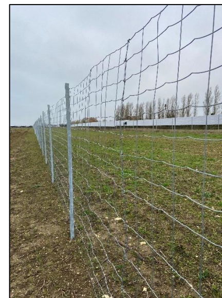
Figure 267 : Illustrations d'une clôture à maille progressive laissant passer la petite faune (Source : BayWa r.e.)
