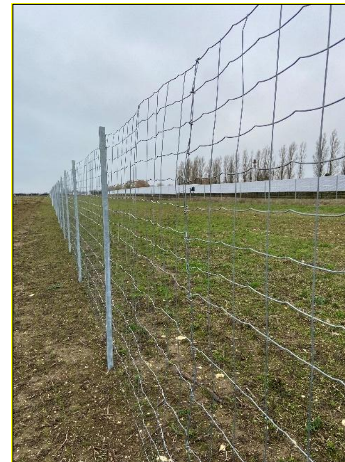
Figure 48 : Illustrations d'une clôture à maille progressive laissant passer la petite faune (Source : BayWa r.e.)
