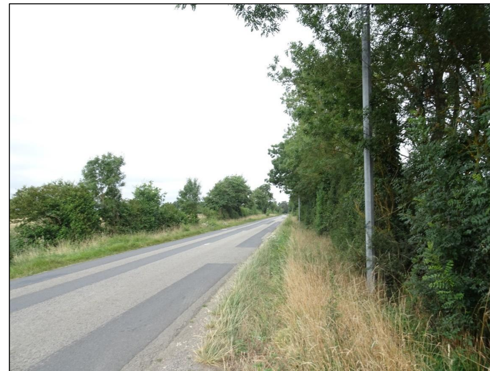
Figure 19 : Route départementale D117 (Source : NCA Environnement - juillet 2022)
