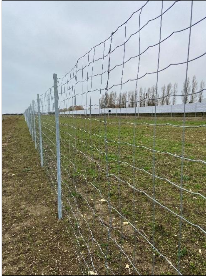
Figure 22 : Illustrations d'une clôture à maille progressive laissant passer la petite faune (Source : BayWa r.e.)
