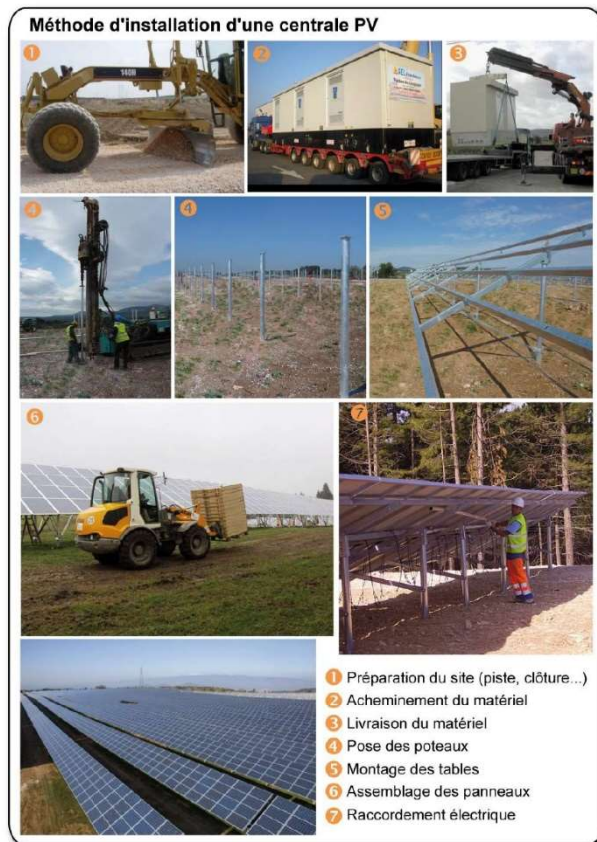
Photographie 8 : Construction d'une centrale photovoltaïque
