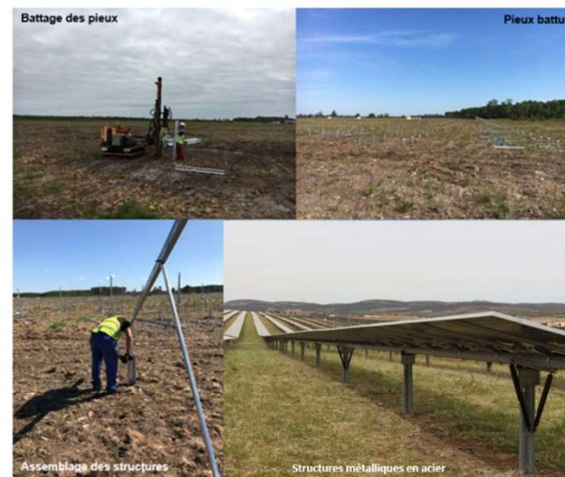
Figure 9 : Structures porteuses métalliques
