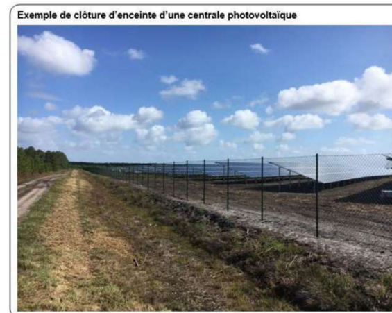
Figure 7 : Clôture de sécurité
