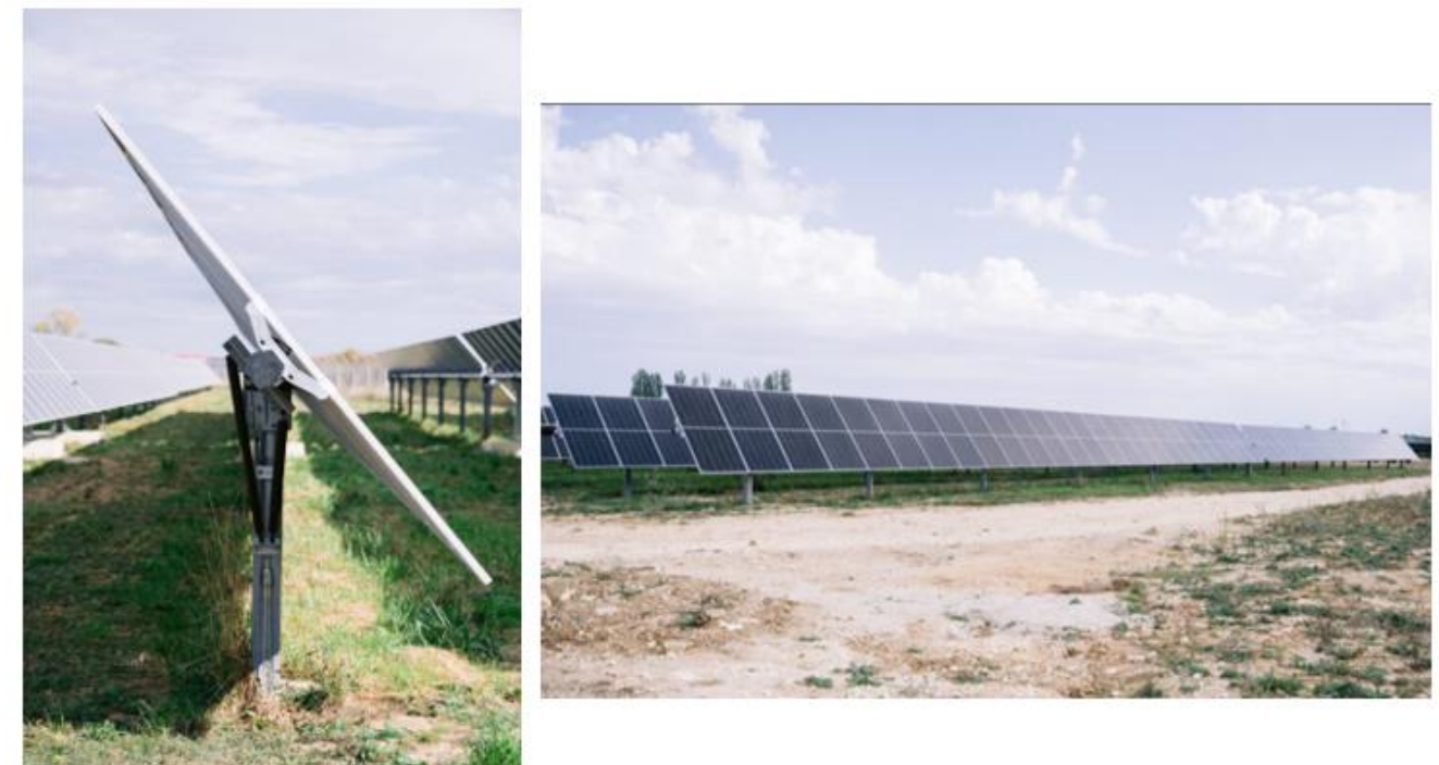
Figure 5 : Photographie d'un parc solaire au sol avec trackers
