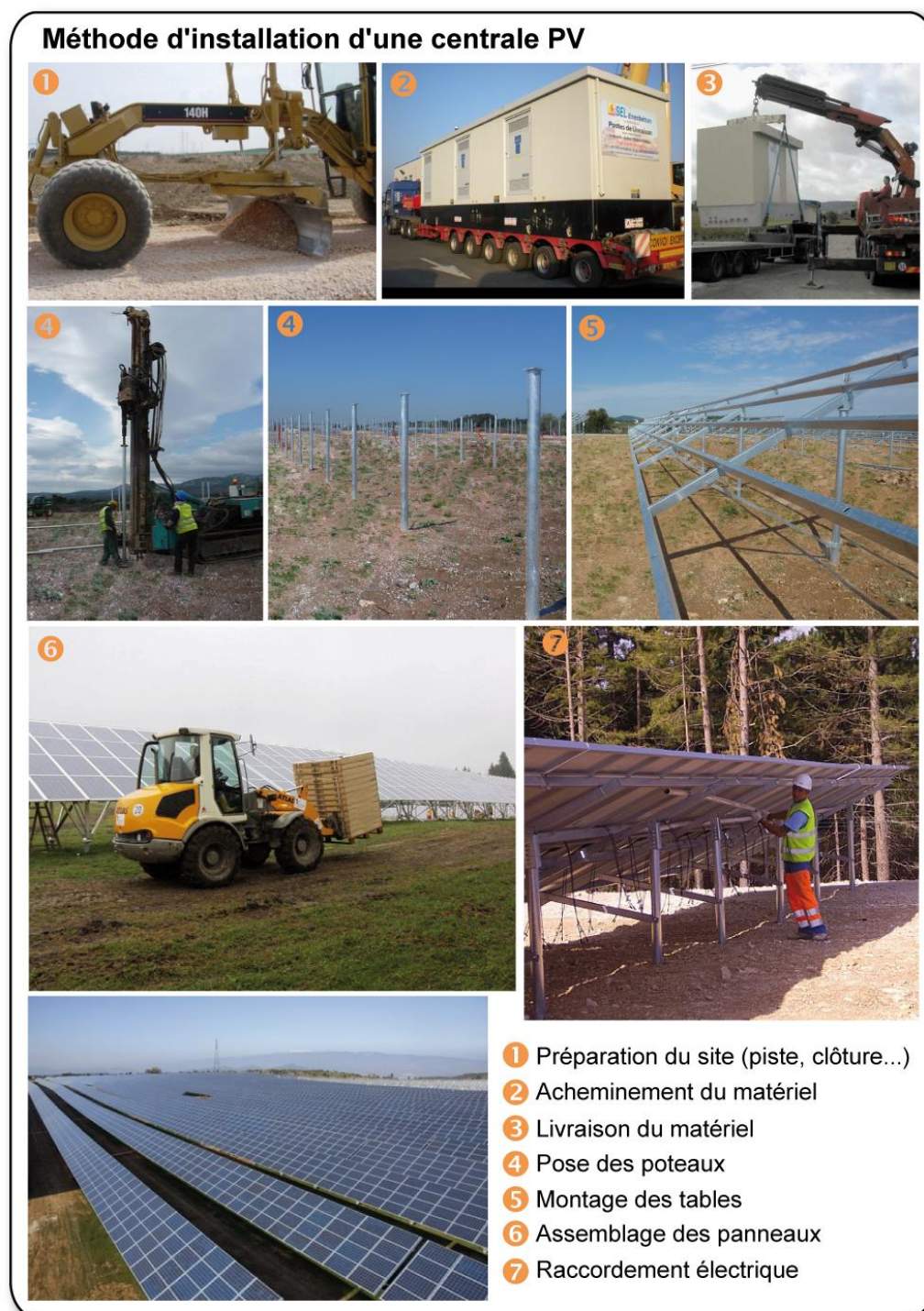
Figure 28 : Construction d'une centrale agrivoltaïque
