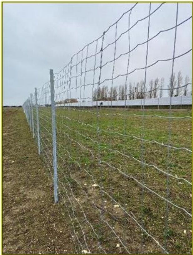
Figure 26 : Illustration d'une clôture à maille progressive laissant passer la petite faune
