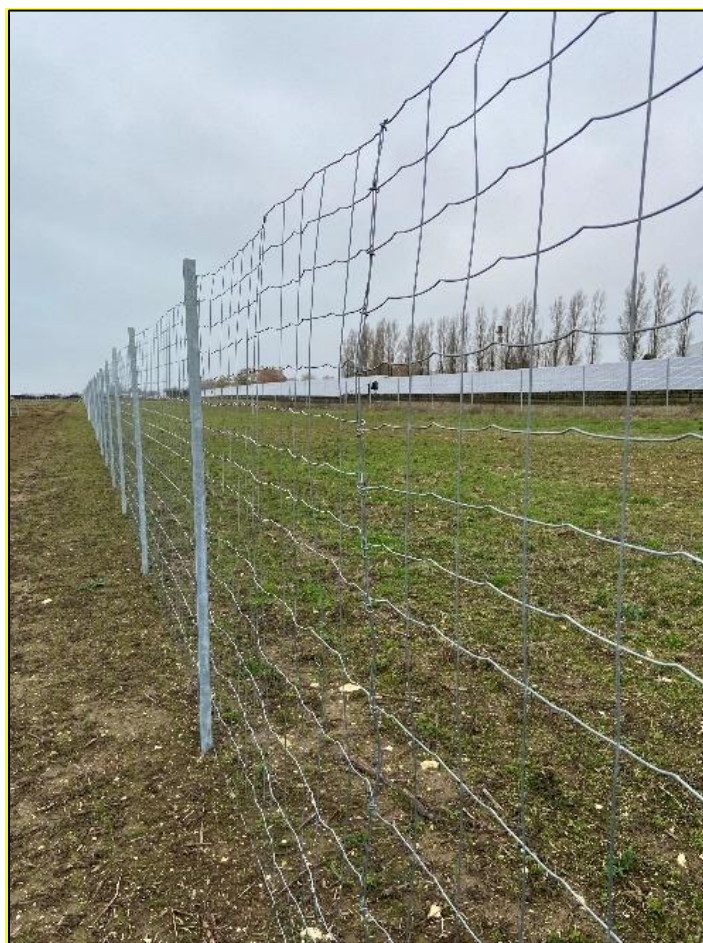
Figure 27 : Illustrations d'une clôture à maille progressive laissant passer la petite faune (Source : BayWa r.e.)
