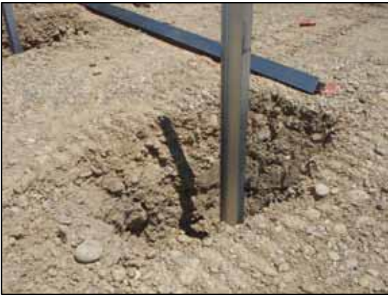
Figure 17 : Types de fondation - pieux battus (Source : Guide MEDDTL 2011 – NCA, 2015)
