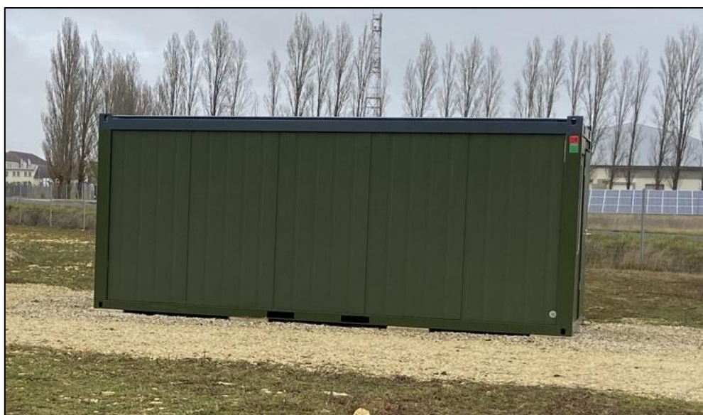
Figure 24 : Container de stockage
