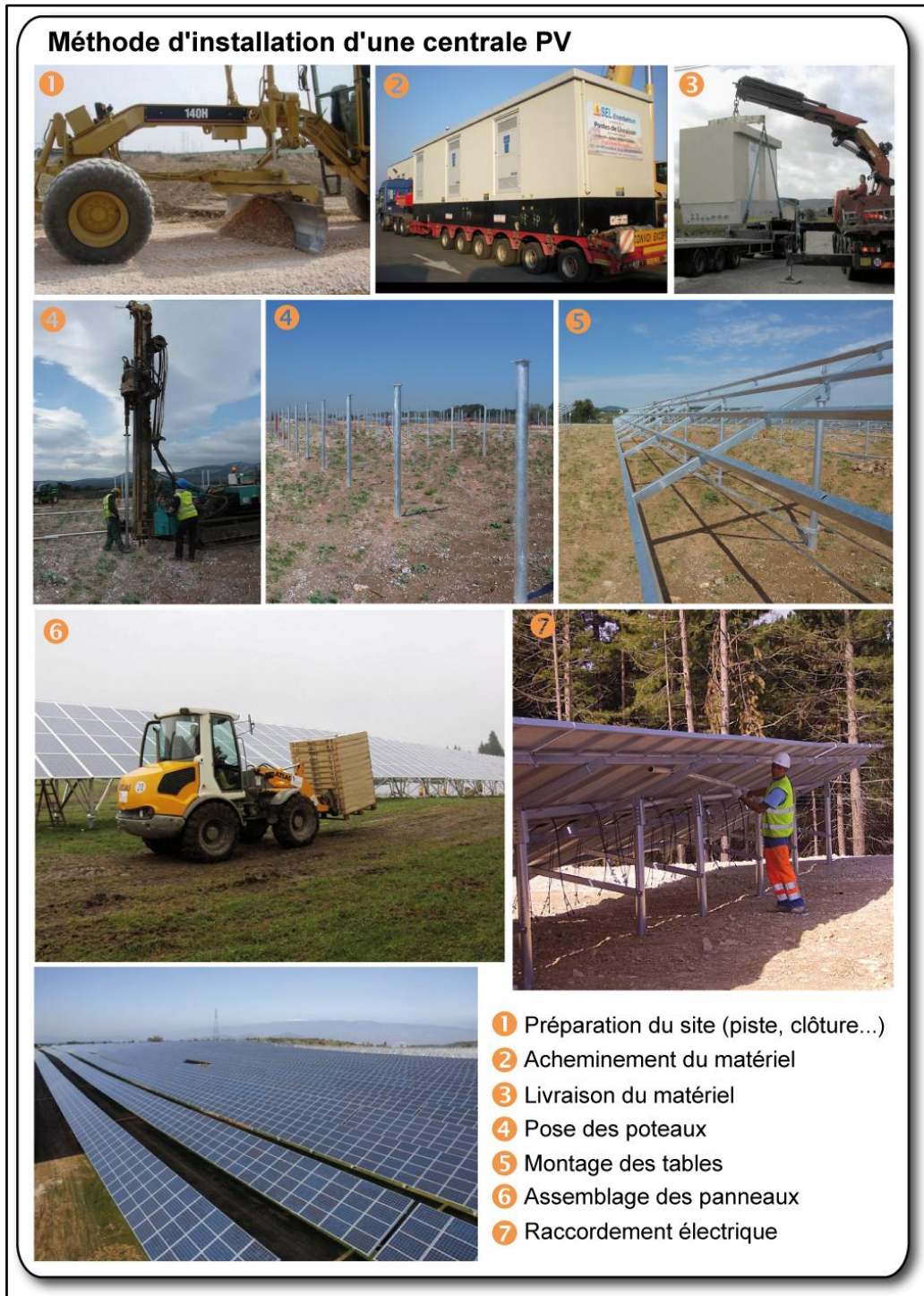
Figure 29 : Construction d'une centrale photovoltaïque (Source : BayWa r.e.)
