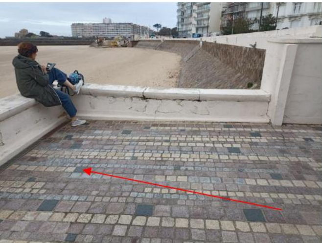
Figure 48 : Altération et fissures diverses au droit du muret en béton - zone devant la piscine (à gauche) / Fissures et fractures colmatées au droit du muret en béton - zone devant le bâtiment (à droite)
