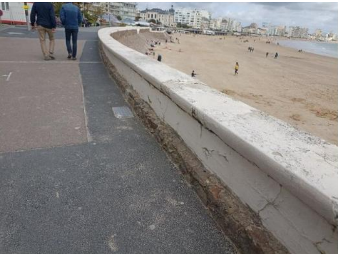
Figure 47 : Altération et fissures diverses au droit du muret en béton (à gauche) / Tête du muret en béton altérée (à droite)
