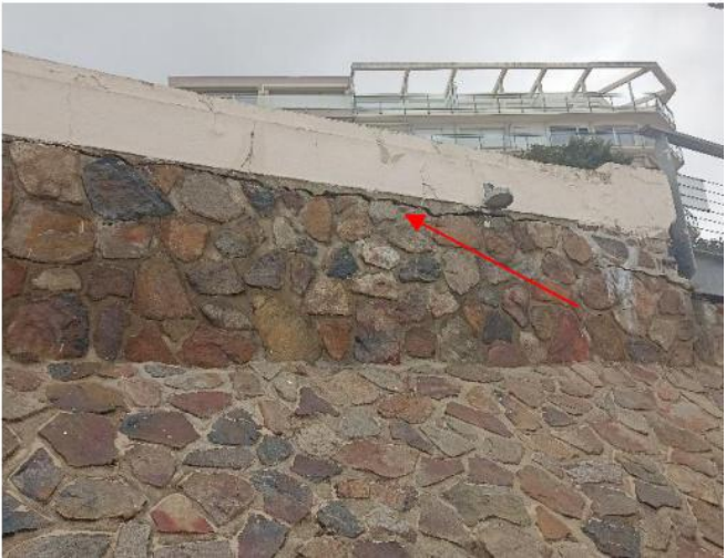
Figure 46 : Fissure verticale au droit des joints au mortier sur toute la hauteur du perré (à gauche) / Fracture horizontale entre le parapet vertical en moellons et le couronnement en béton (à droite)
