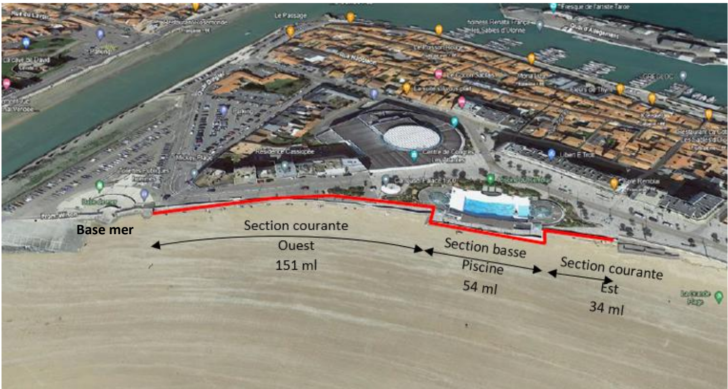
Figure 3 : Ouvrage à traiter
