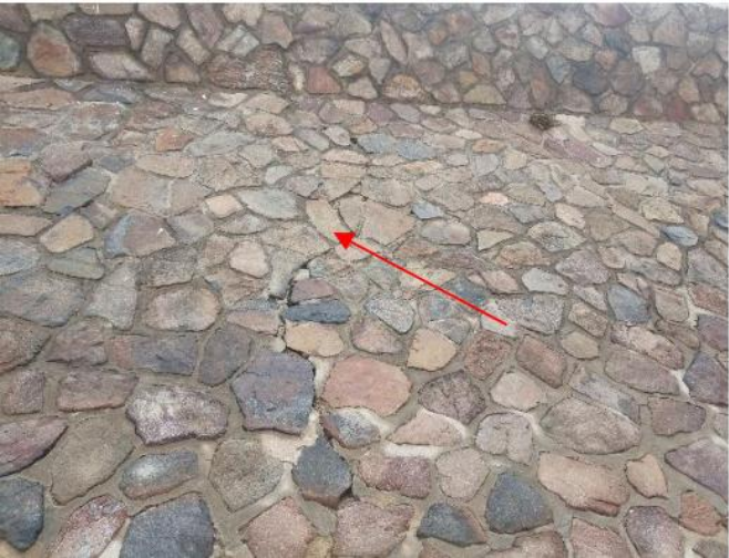
Figure 46 : Fissure verticale au droit des joints au mortier sur toute la hauteur du perré (à gauche) / Fracture horizontale entre le parapet vertical en moellons et le couronnement en béton (à droite)
