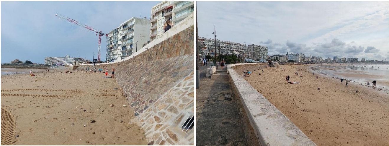
Figure 4 : Vue depuis la plage (section courante Ouest) à gauche – Vue depuis le haut du mur (section courante Ouest) à droite - ARTELIA, août 2025
