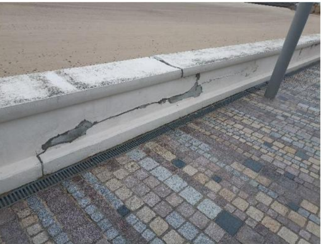
Figure 48 : Altération et fissures diverses au droit du muret en béton - zone devant la piscine (à gauche) / Fissures et fractures colmatées au droit du muret en béton - zone devant le bâtiment (à droite)
