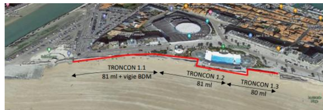
Figure 63 : Phases de réhabilitation des ouvrages de défense contre la mer
