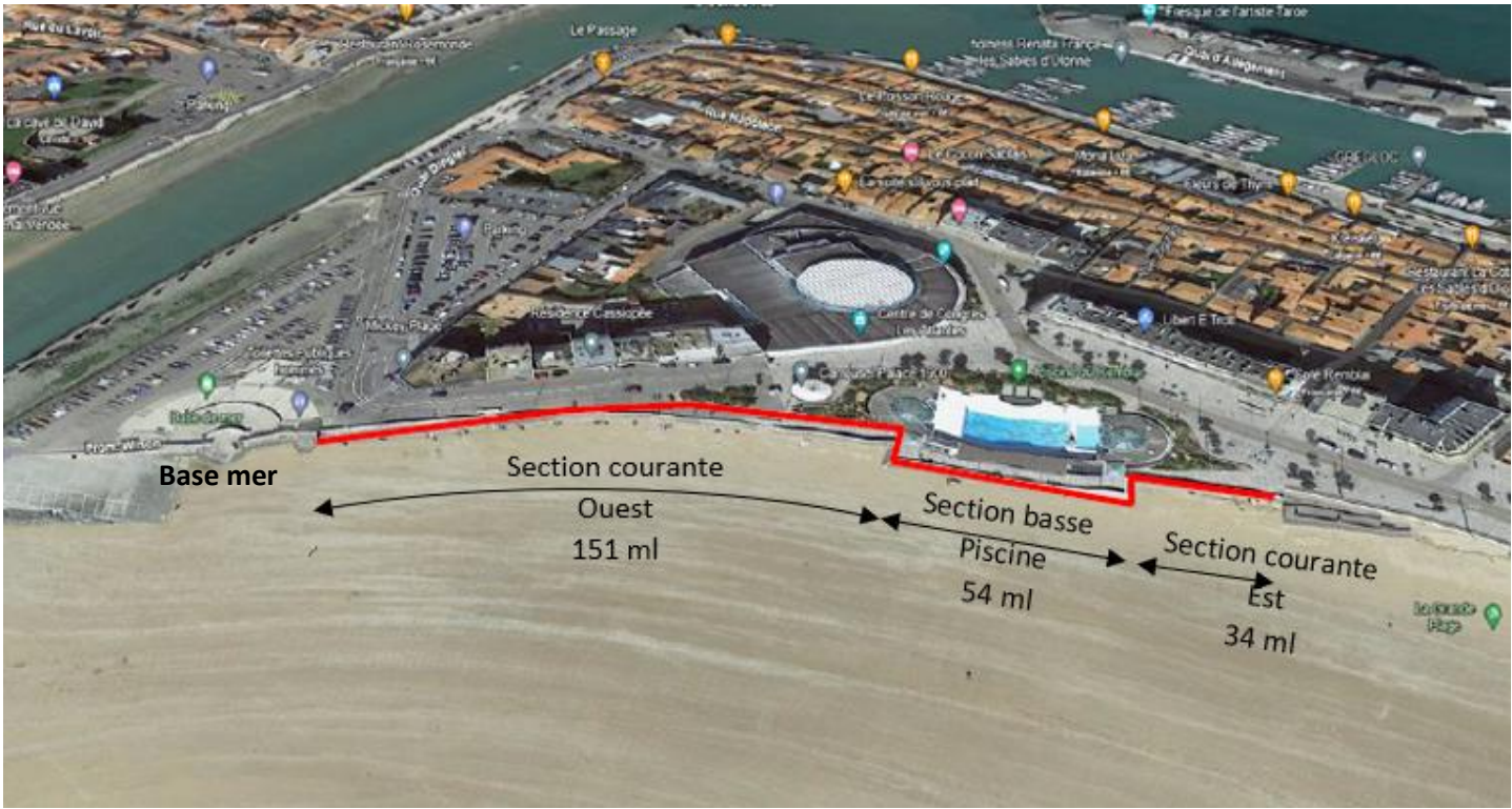
Figure 2 : Ouvrage à traiter
