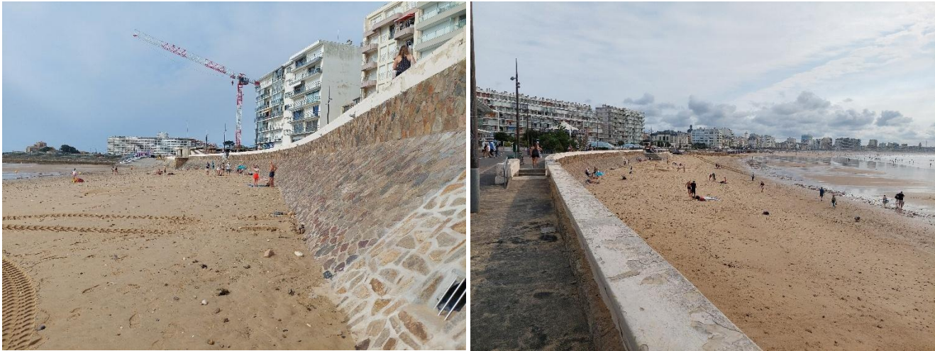
Figure 3 : Vue depuis la plage (section courante Ouest) à gauche – Vue depuis le haut du mur (section courante Ouest) à droite - ARTELIA, août 2025
