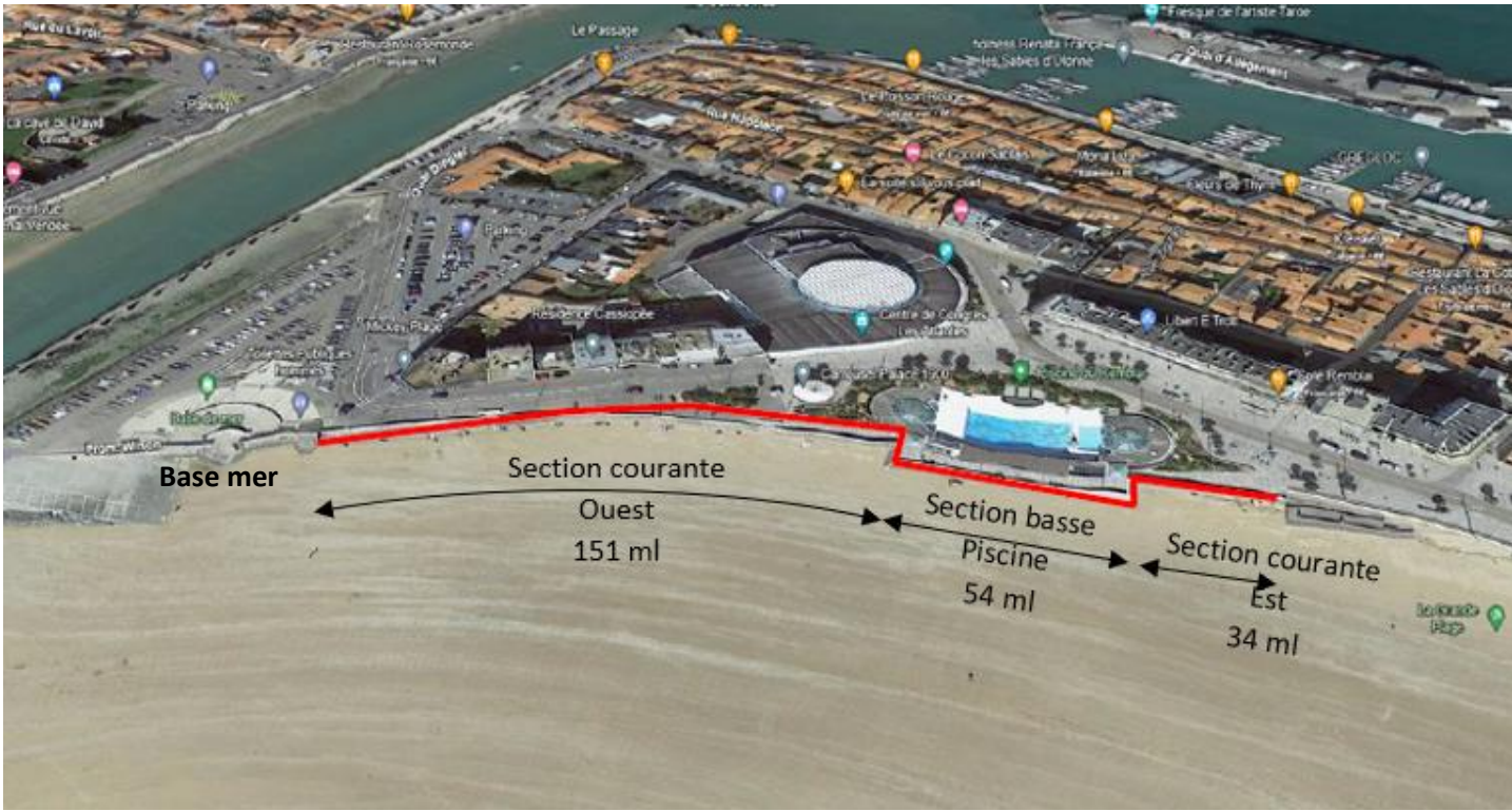
Figure 2 : Ouvrage à traiter
