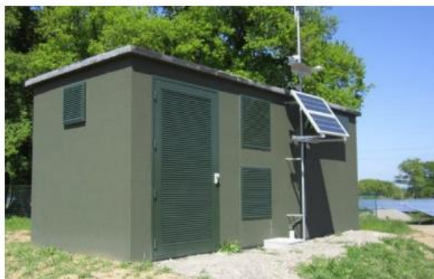
Photographie 85 : Exemple d'un local peint en vert sombre (Source : ENCIS Environnement)
