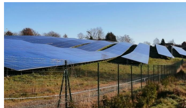
Photographie 3 : Exemple d'installation photovoltaïque au sol (Source : ENCIS Environnement)
