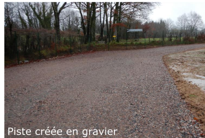
Photographie 6 : Pistes internes (Source : ENCIS Environnement)
