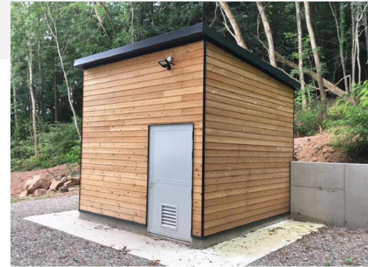
Exemple d'un bâtiment de prise d'eau (F247)
