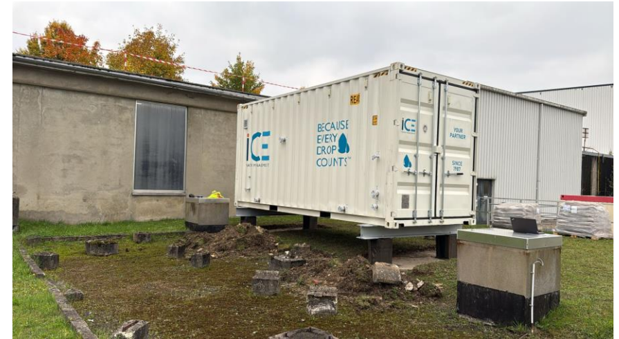
Exemple d'une solution de traitement de l'eau dans un conteneur 6m de long
