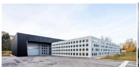
Local administratif du Grand-Est
