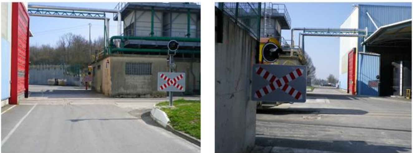
Figure 6 : Vues sur les voies ferrées au niveau des halls 1 et 10
