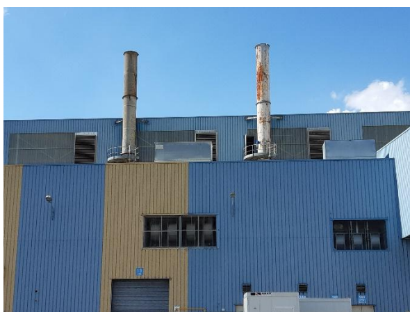
Figure 29 : Vue sur les deux incinérateurs L2
