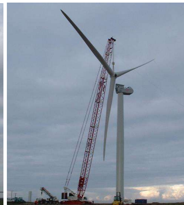
Photo 12 : montage du rotor
