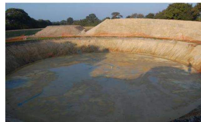
Photo 7 : excavation pour fondation
