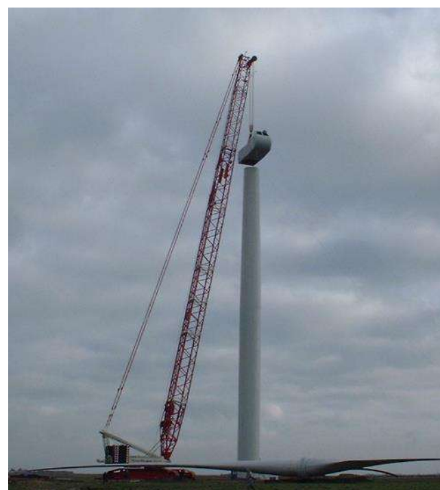
Photo 11 : montage de la nacelle
