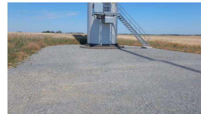
Photo 4 : plateforme au pied d'une éolienne
