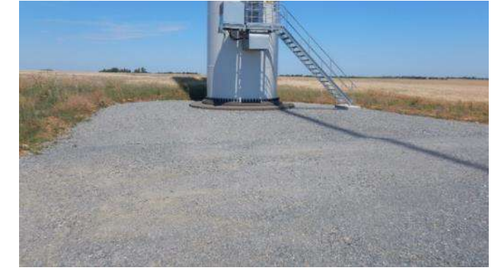
Photo 43 : plateforme au pied d'une éolienne
