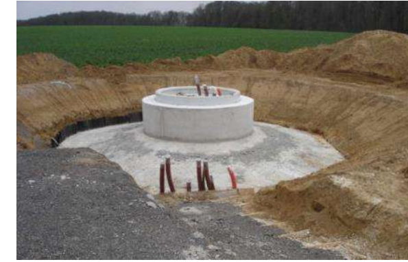
Photo 42 : fondation d'éolienne
