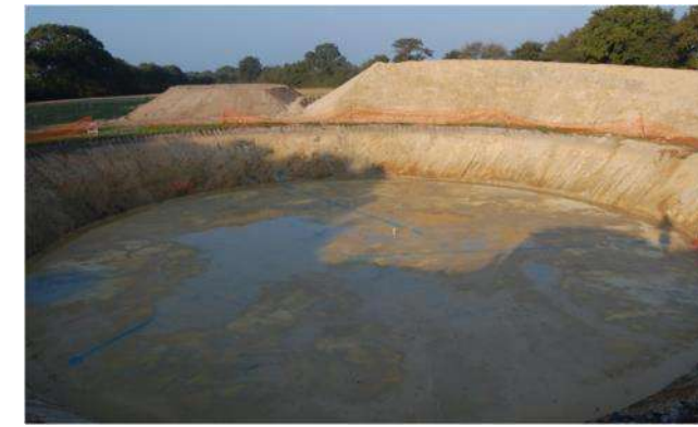
Photo 48 : excavation pour fondation
