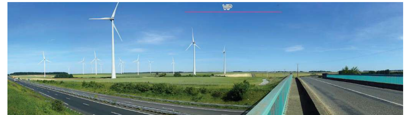
Photo 26 : - Depuis le franchissement de l'autoroute A20 par la RD 68, on peut voir que les vues en direction du VIP (Volume d'Implantation Potentielle des éoliennes) sont localement fermées par un talus et que les vues latérales sont marquées par les parcs éoliens présents à proximité immédiate
