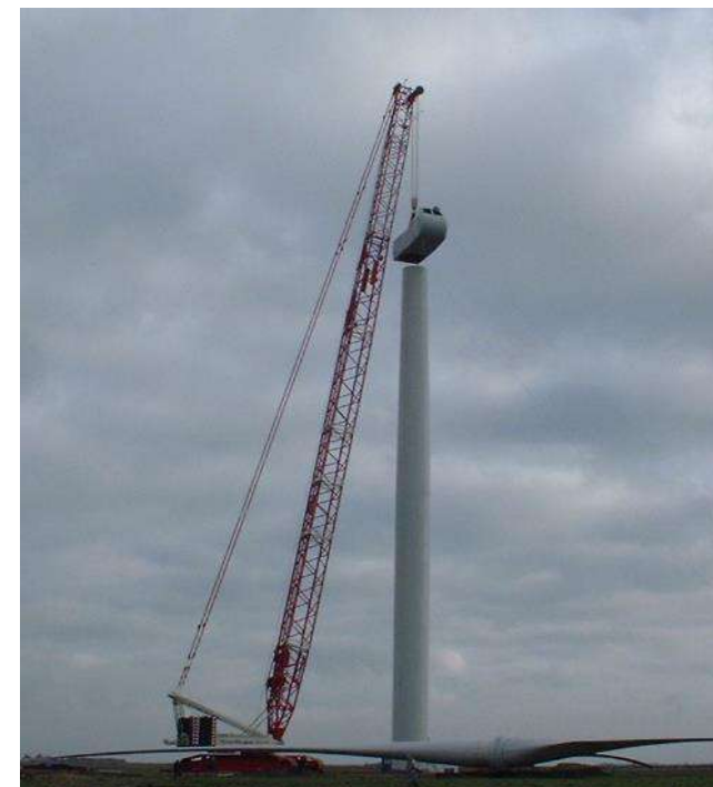
Photo 52 : montage de la nacelle
