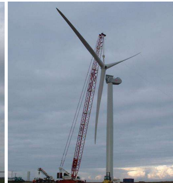
Photo 53 : montage du rotor
