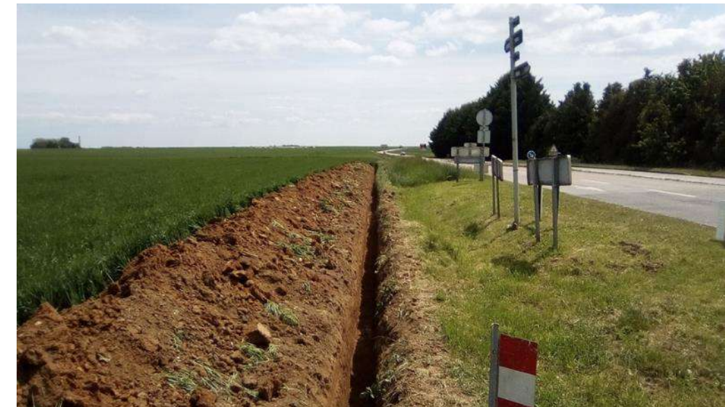
Photo 3 : Tranchée pour le passage de réseau électrique HTA à partir d'une pelle mécanique (Source : VALOREM)
