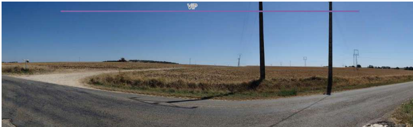
Photo 28 : Depuis cette portion de la RD 28 au plus près de la zone d'étude, le VIP est visible de manière latérale par rapport à l'axe de la route avec une hauteur apparente importante et une large emprise
