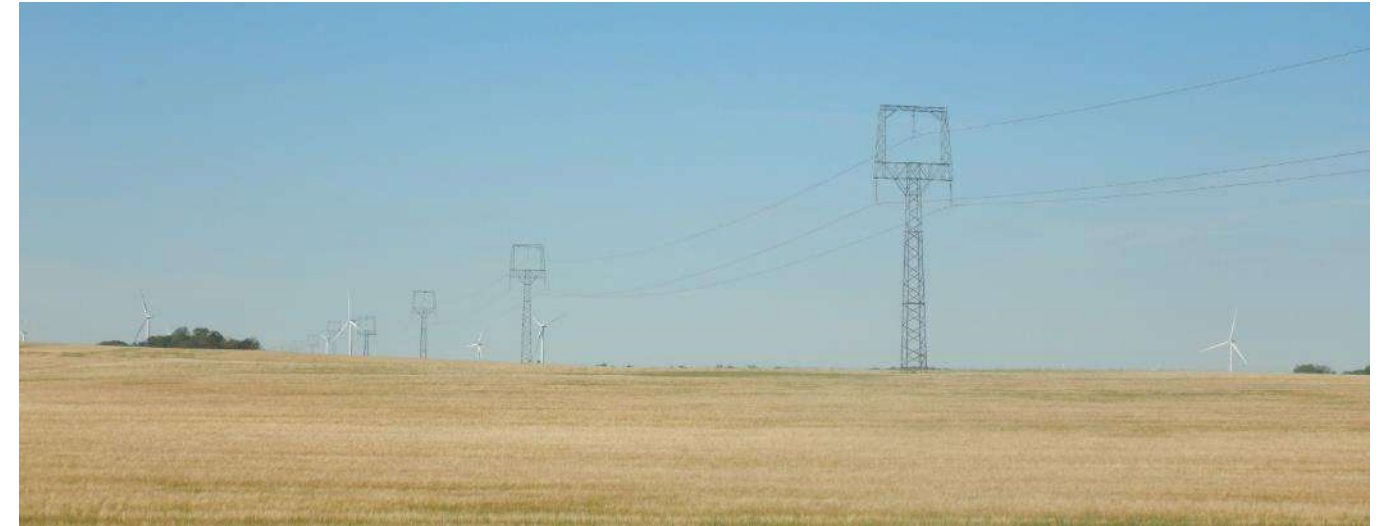
Photo 19 : ligne électrique HTB sur la zone d'implantation potentielle
