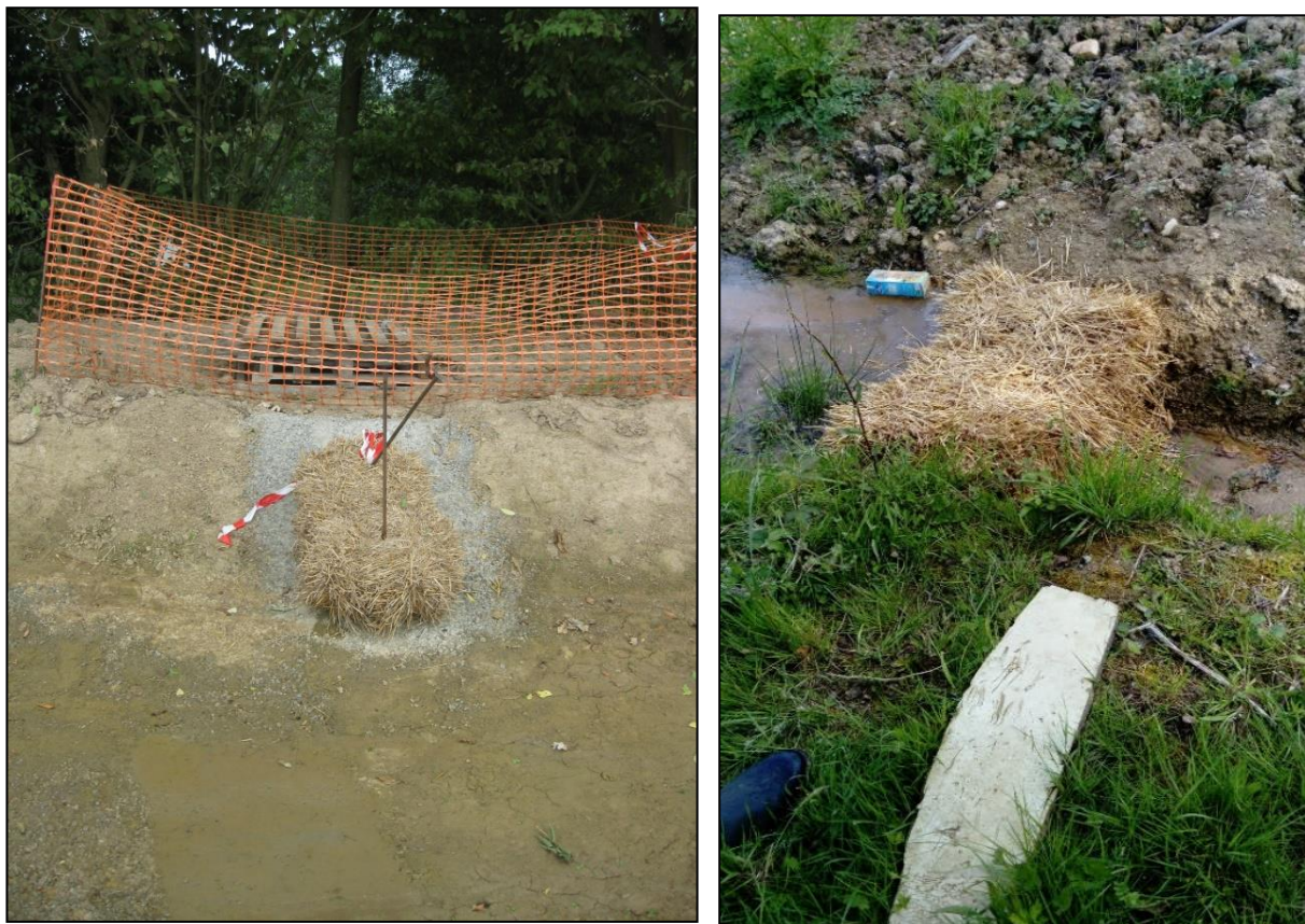
Figure 29 : Emplacements du filtre à particules fines (botte de paille) pendant la phase des travaux au niveau du bassin d'orage
