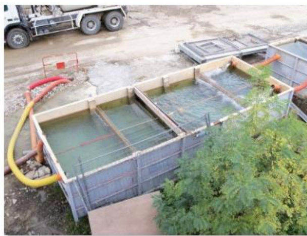
Figure 35 : Exemple de décanteurs horizontaux pour le traitement des eaux de rabattement de nappe
