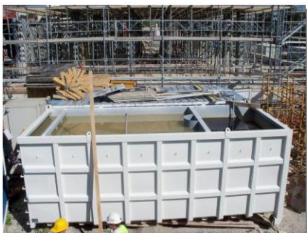
Figure 35 : Exemple de décanteurs horizontaux pour le traitement des eaux de rabattement de nappe
