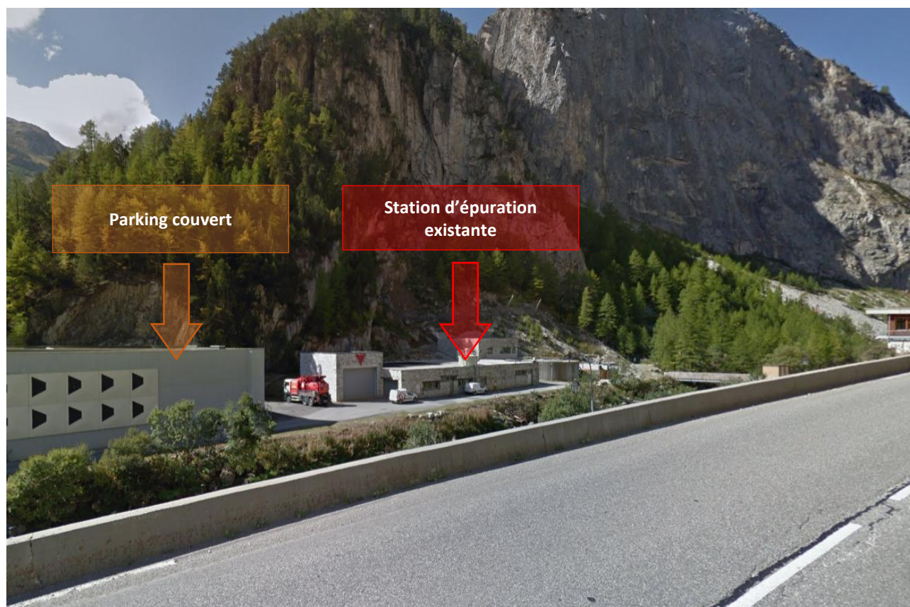
Figure 32 : Site de la station d'épuration existante vu depuis la RD902 (prise de vue septembre 2018 - Google Maps/Street View)
