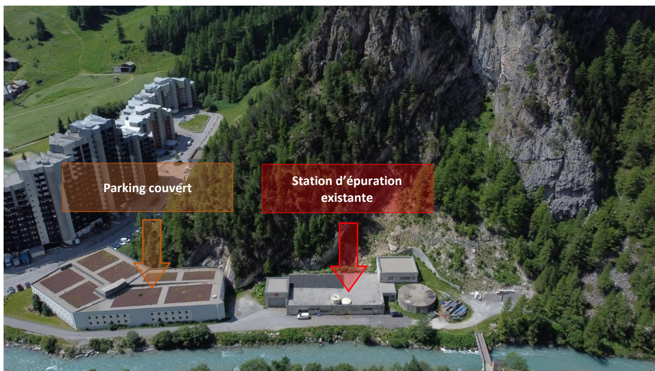
Figure 31 : Vues aériennes du site de la station d'épuration existante (prises de vue par drone juillet 2024 - ANTEA)
