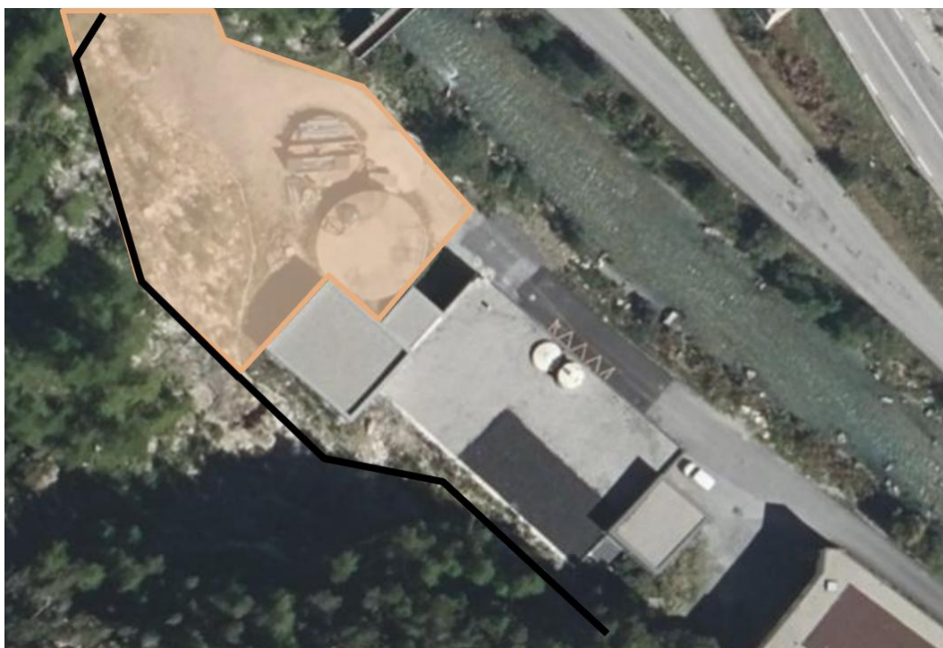
Phase 1 : Déblais des éboulis
