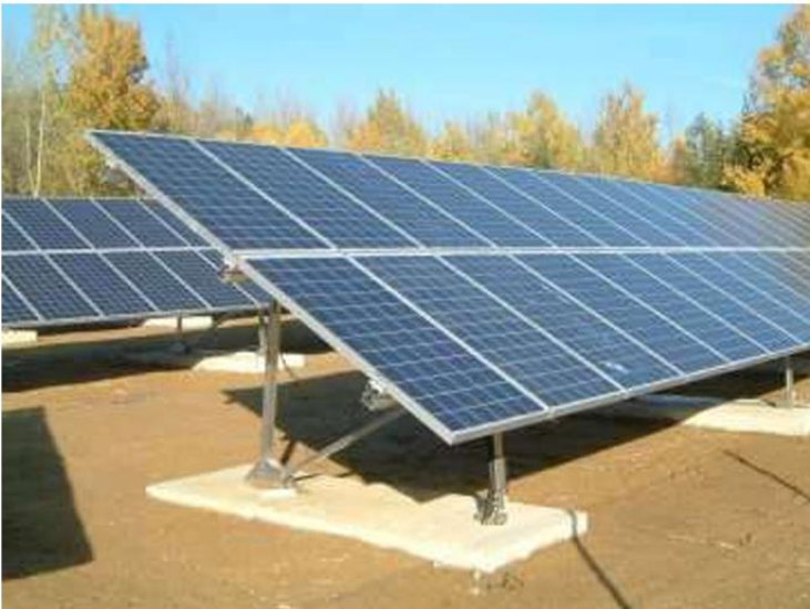
Photo 1 : Ancrage au sol par plots bétons
