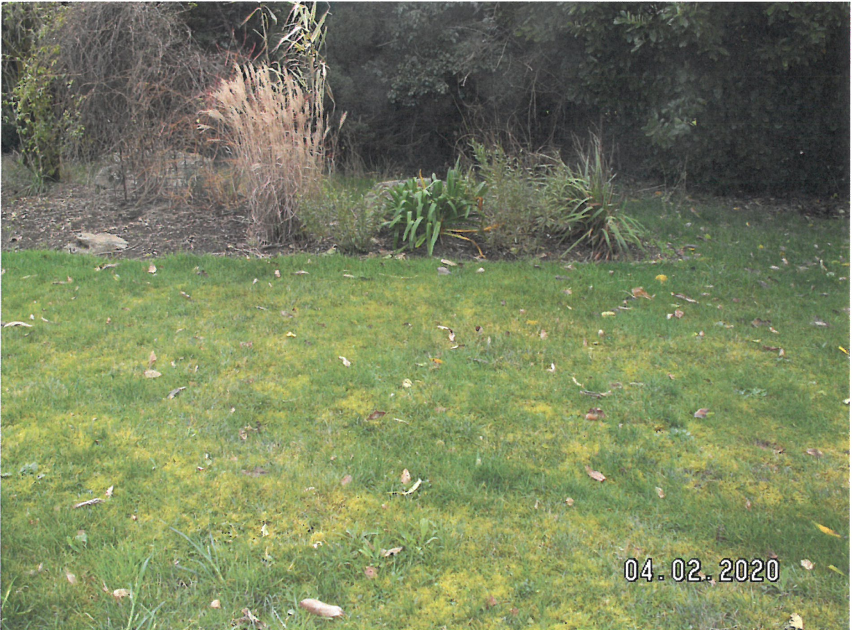
Aspect superficiel du "puisard-avaloir" d'infiltration des eaux pluviales.
