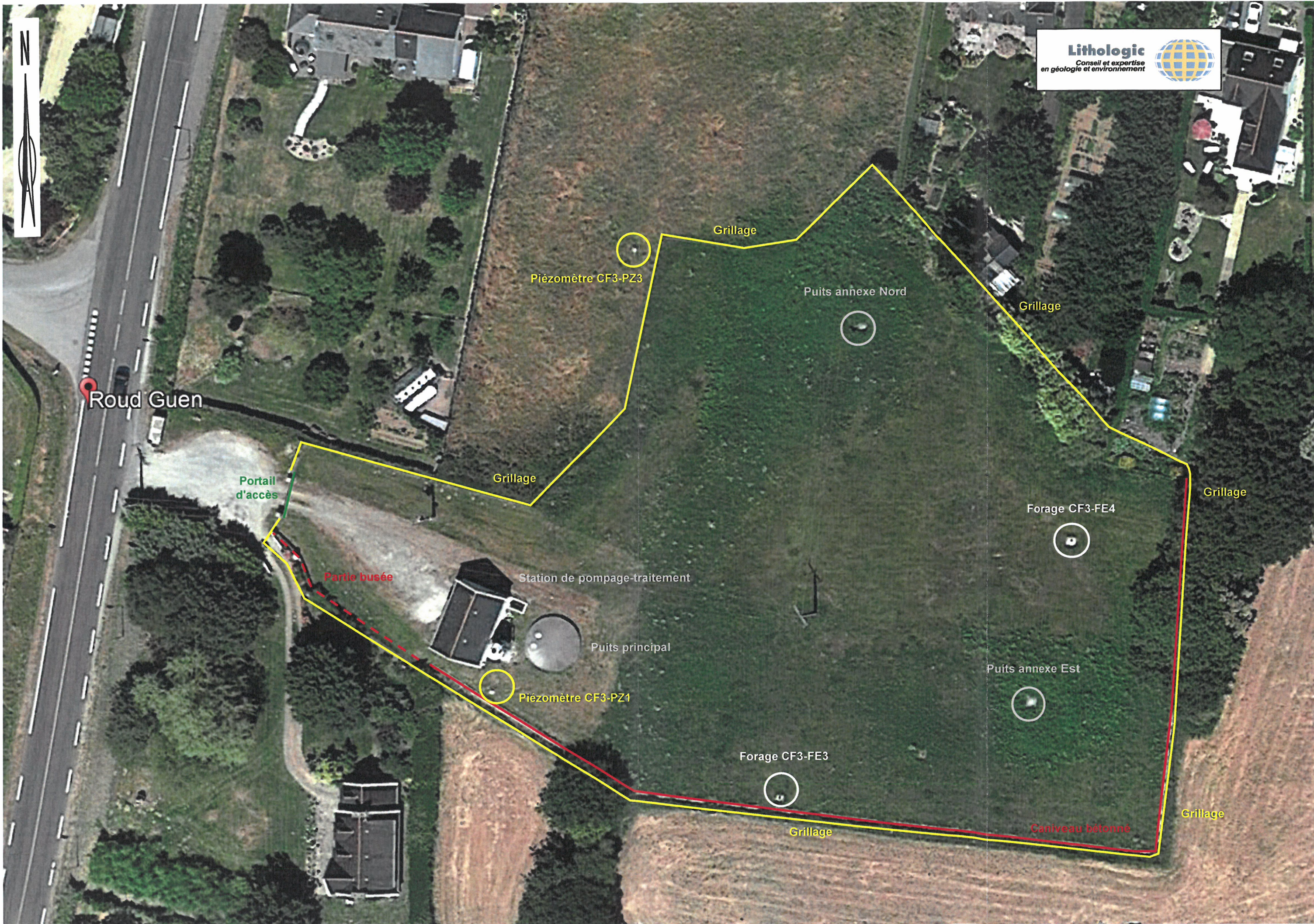
Fig. 8 : Environnement immédiat autour des forages CF3-FE3 et CF3-FE4 de Roud Guen [commune de Clohars-Fouesnant (29)].
