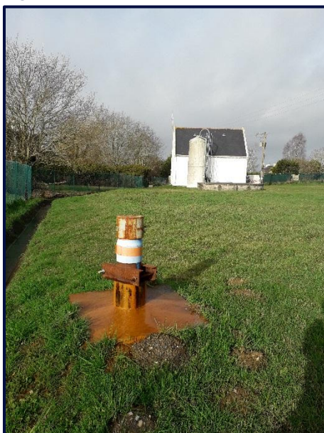
Figure 1 : Photographie du forage CF3-FE3
