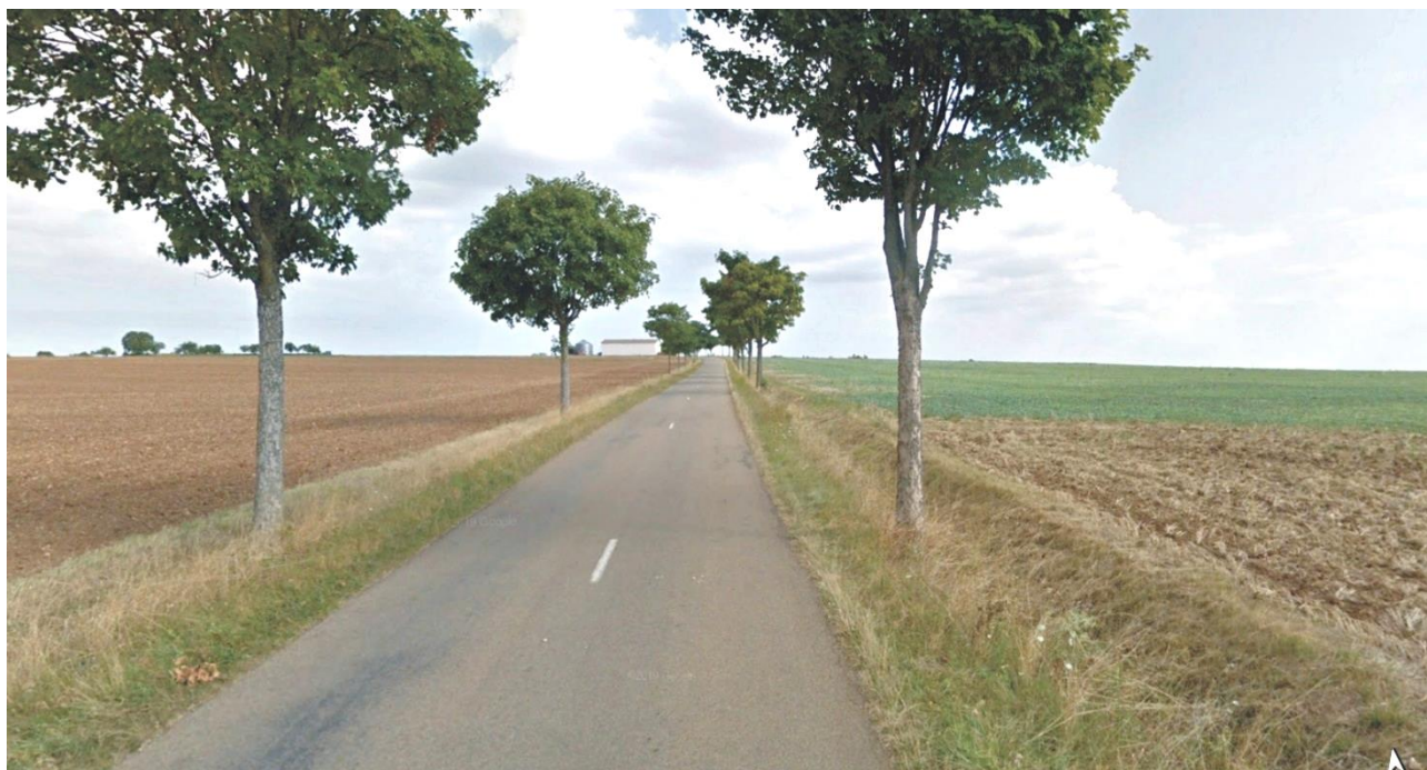
A droite de la RD13c, fossé infranchissable, nécessitant le busage
