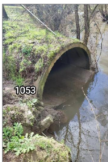
Figure 15 : Ouvrage hydraulique du ruisseau de Muhlbach vu sur le site par SAGE Environnement en 2024 et par GUELLE et FUCHS en 2024
