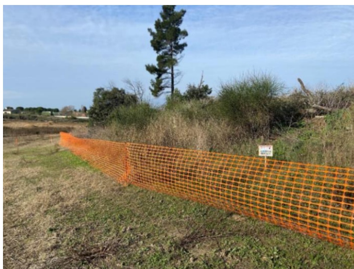
Figure 57 : Exemple de balisage et de panneaux pour la mise en défend des zones sensibles (MR13)
