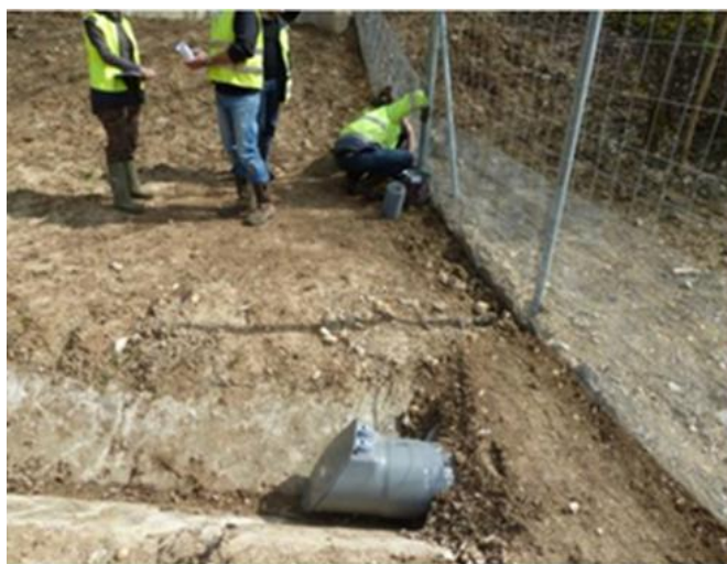
Figure 58 : Exemple de grillage à maille fine installé au bas d'un grillage à maille large – barrière amphibie MR14
